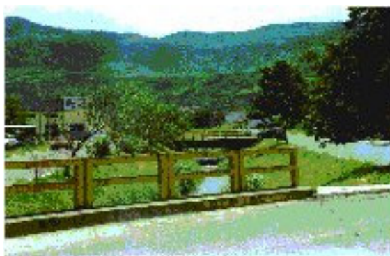
Figura 9: canalização dos arroios e pavimentação asfáltica.
