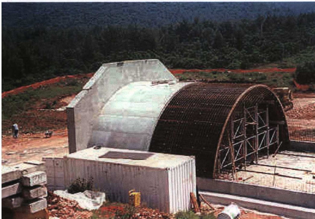
Figura 5: estrutura em forma de 'iglu', concretada com CAA (fonte: BERNABEU e LABORDE, 2000, p.11)
