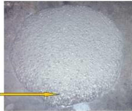
Figura 7: CAA tendendo a segregar (MBT, 2004)
