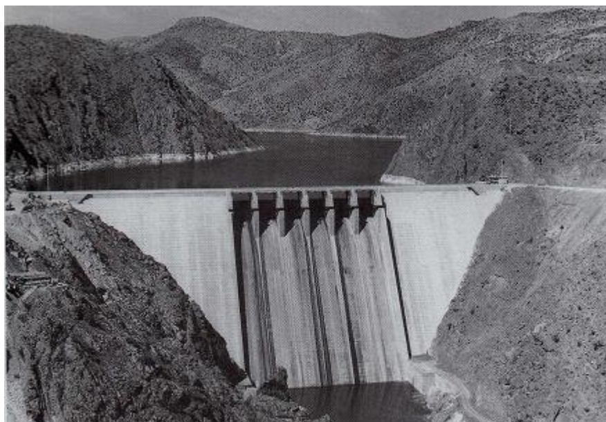
Figura 9 – Barragem Sariyar, Turquia – barragem de gravidade com vertedouro no corpo da barragem
