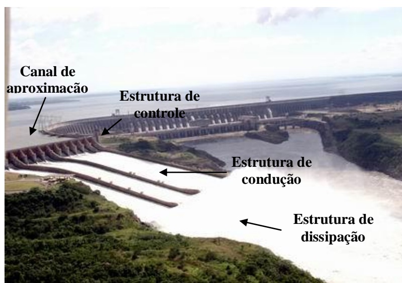
Figura 8 – Identificação de elementos básicos de um sistema extravasor – usina hidrelétrica de Itaipu
