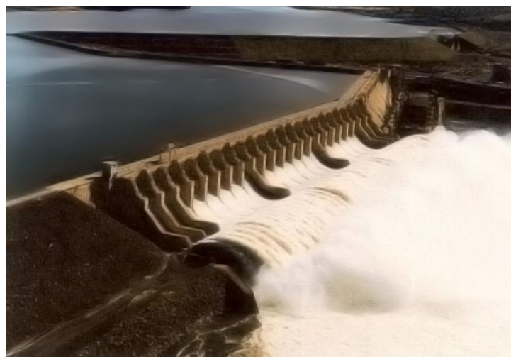
Figura 13 – Barragem de Tucuruí – vertedouro com salto de esqui no corpo da barragem
