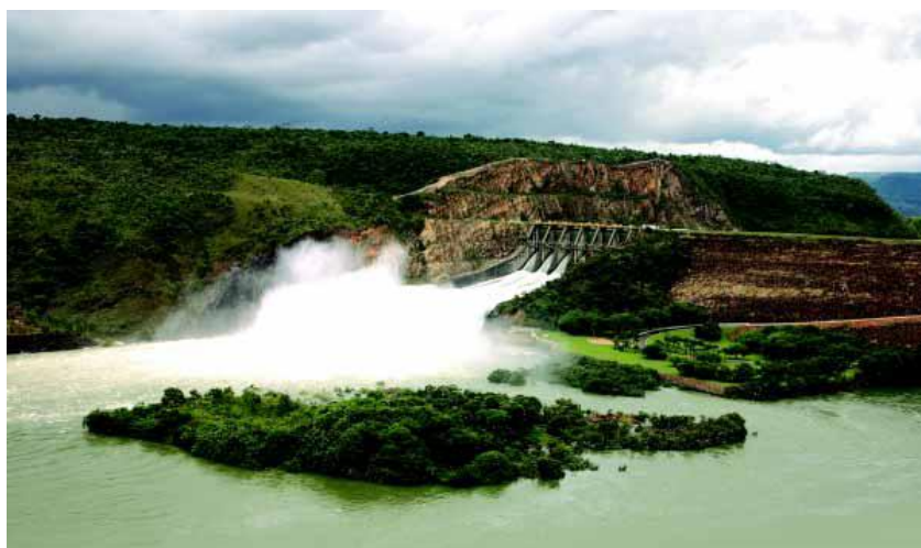
Figura 10 – Barragem Luiz Carlos Barreto de Carvalho (Estreito) – barragem de enrocamento com vertedouro em concreto na ombreira direita
