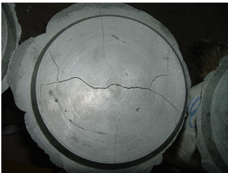
Figura 23 – Fissuras provocadas pela retração excessiva da mistura
