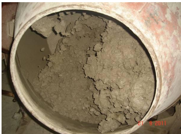
Figura 11 – concreto sendo misturado
