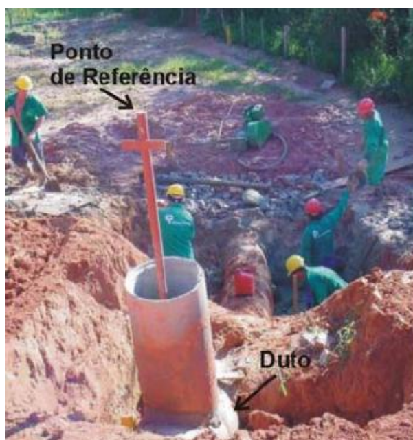
Figura 15 – Abraçadeira para monitoramento de deslocamentos em dutos
