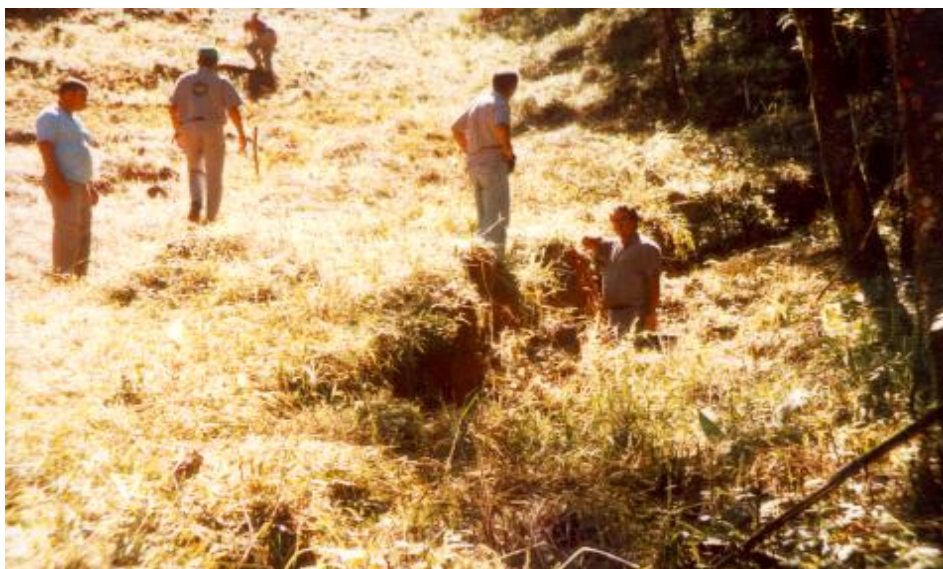
Figura 19 – Fendas de tração devido ao movimento coluvionar
