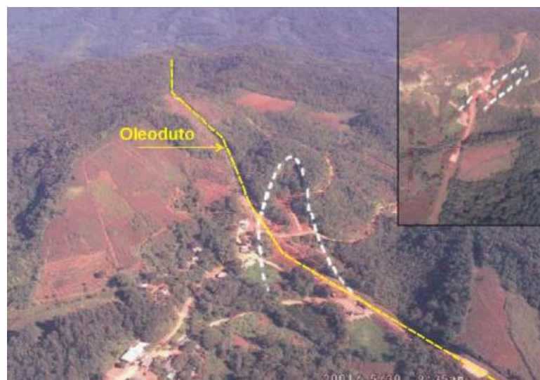
Figura 12 – Vista aérea do local do acidente
