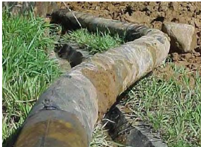
Figura 10 – Ruptura de tubulação por flambagem
