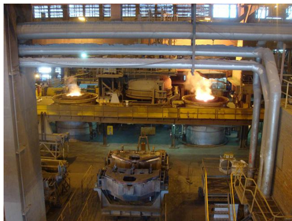
Figura 21. Tanques VD/VOD da Gerdau Charqueadas Fonte: Cortesia da Gerdau Charqueadas (2011)
