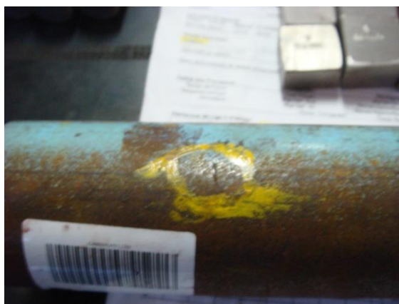
Figura 24. Barra com marcação de defeito do tipo MI após ter sido inspecionada
