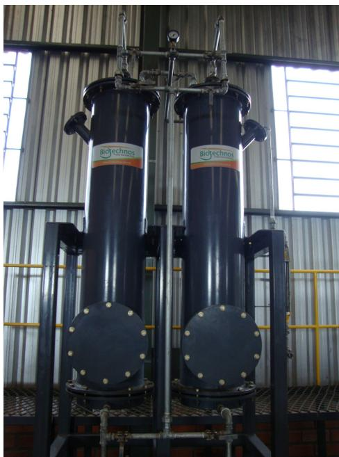
Figura 4.8 – Torres para purificação do biodiesel de OGR após a separação das fases
