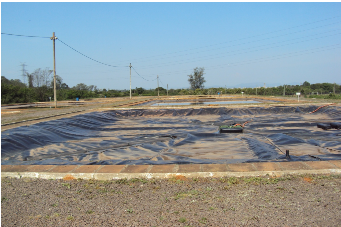
Figura 3.2: fotografia das lagoas que compõem o sistema de tratamento de lixiviados.
