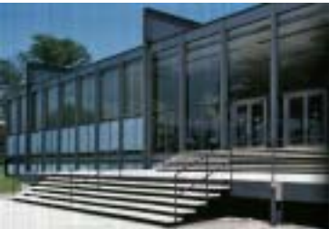
14 Mies van der Rohe. Crown Hall, vista parcial externa. Chicago, 1950-56
