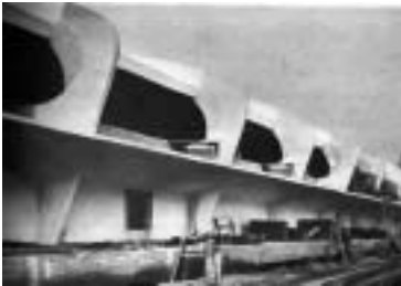
48 Vista durante a obra
