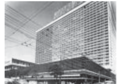
7 David Libeskind, Edifício Conjunto Nacional. São Paulo, 1955
