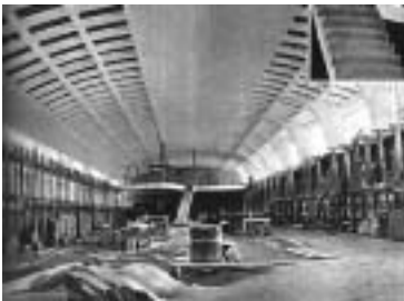
50 Vista interna da estrutura de concreto armado
