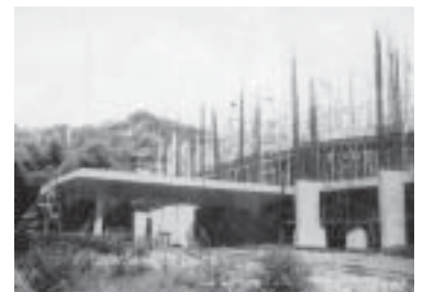
16 A obra em andamento
