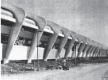
47 Vista durante a obra
