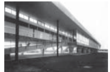
8 Colégio Brasil-Paraguay. Vista da fachada posterior com a rampa. Reidy, Assunção, 1948
