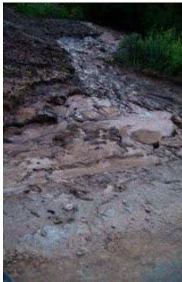
Figura: 08 valo aberto para o desvio das águas das estradas, ele arrasta muita terra para o arroio.(HARTWIG, 2011).
