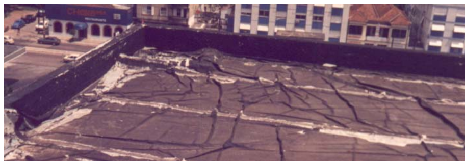
Figura 55: envelhecimento precoce da manta.
