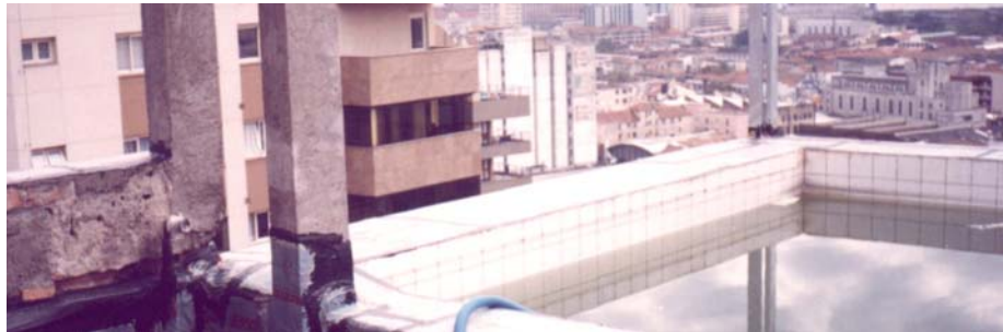
Figura 2: execução de piscina em cobertura.
