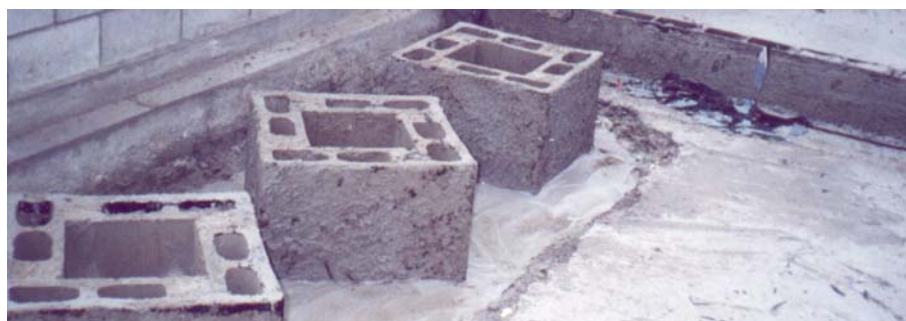
Figura 68: obra em cobertura, posterior à impermeabilização.
