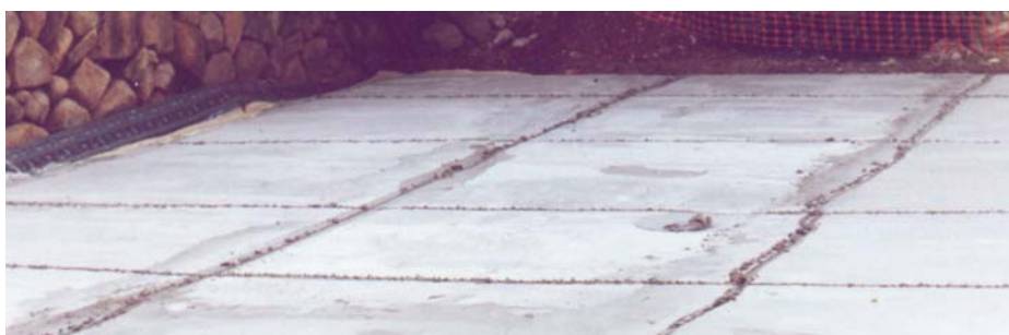
Figura 51: execução da proteção mecânica possibilita o trânsito do pessoal de obra.
