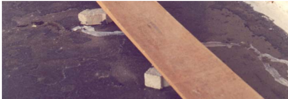
Figura 19: aplicação de emulsão asfáltica em laje de cobertura.
