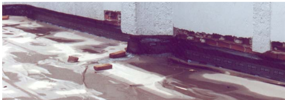
Figura 36: execução de camada de separação com utilização de papel kraft .
