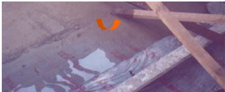
Figura 42: materiais pontiagudos podem causar danos à impermeabilização.
