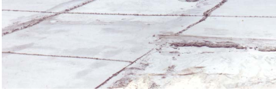
Figura 11: execução da proteção mecânica tem por finalidade evitar danos à impermeabilização.
