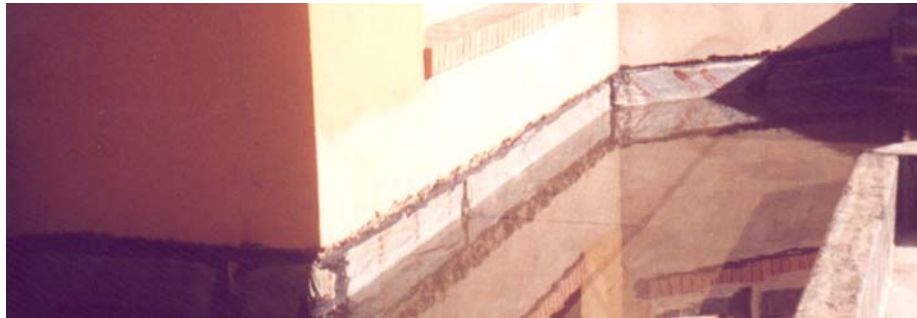
Figura 35: teste hidrostático em execução.
