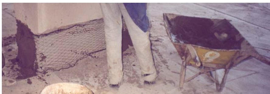
Figura 58: execução de tela de estuque em rodapé
