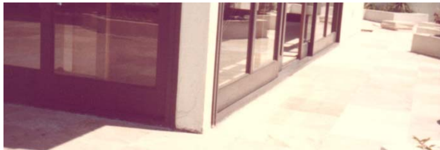
Figura 3: construção de novos compartimentos em cobertura.
