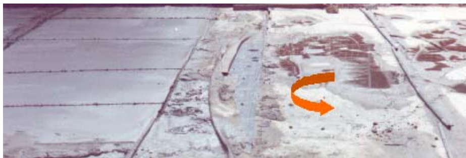
Figura 50: execução de camada separadora evita danos à impermeabilização.
