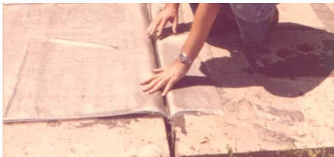
Figura 66: passo na execução de junta de dilatação.
