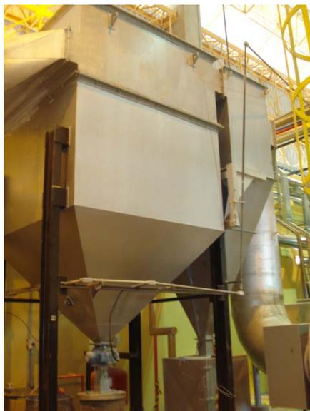
Figura 18 - Multiciclone para remoção de partículas e de fagulhas.
