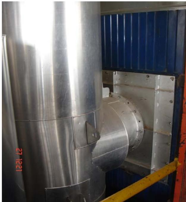
Figura 17 - Detalhe do insuflamento de gases na caldeira.
