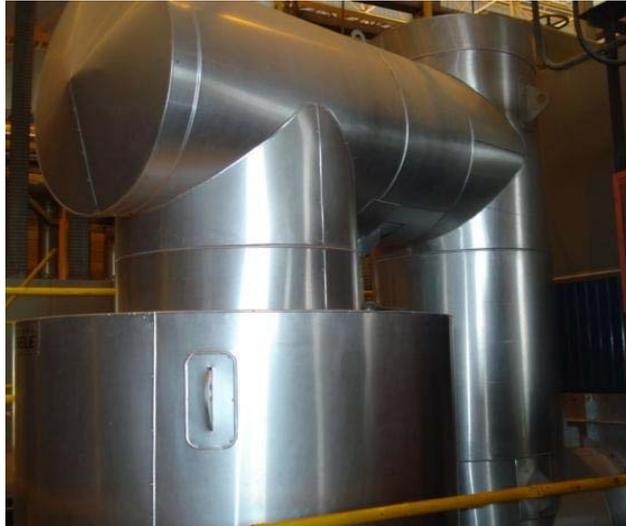
Figura 16 - Tubulação de insuflamento de gases quentes na caldeira.
