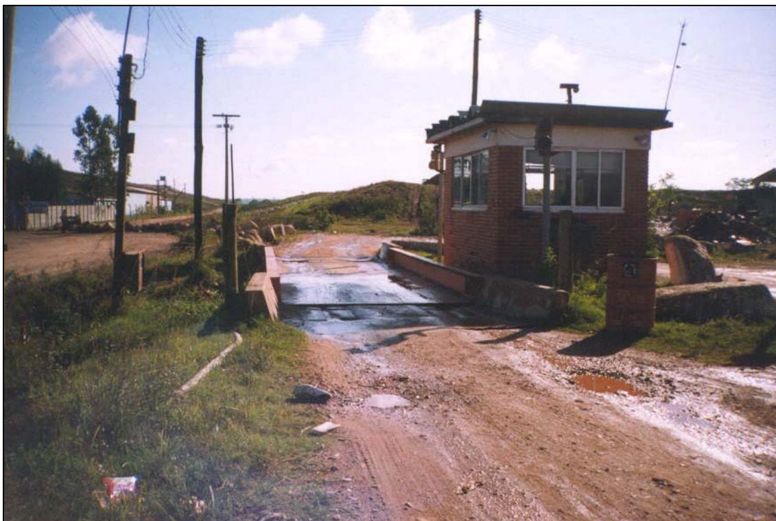
Figura C16 – Balança para pesagem de caminhões de resíduo. Ao fundo, vista da Célula 4 do Aterro Sanitário Zona Norte.
