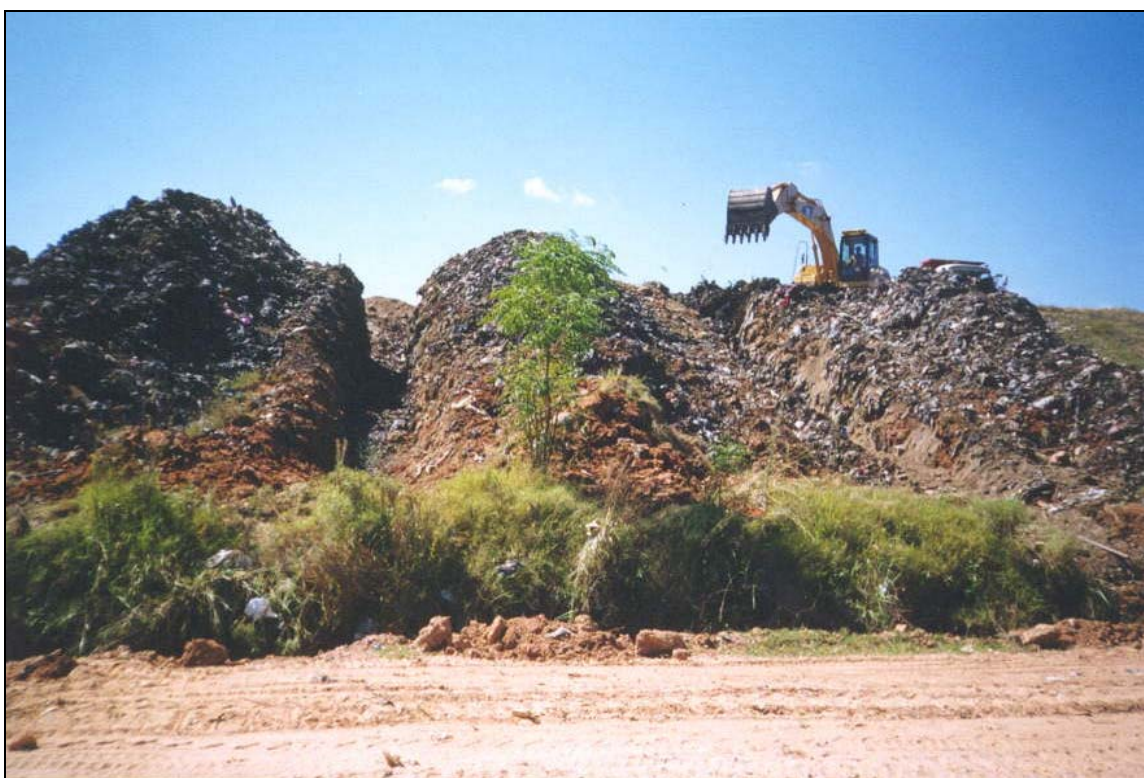
Figura C4 – Valas das células C5 e C6. Recolocação de resíduo na vala da célula C6.
