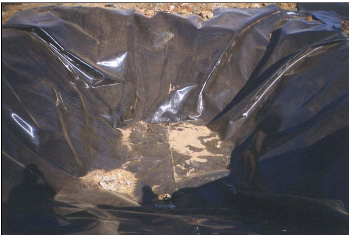
Figura C10 – Lâmina de PEAD 2 mm cobrindo a célula C6, aguardando cortes para melhor assentamento.
