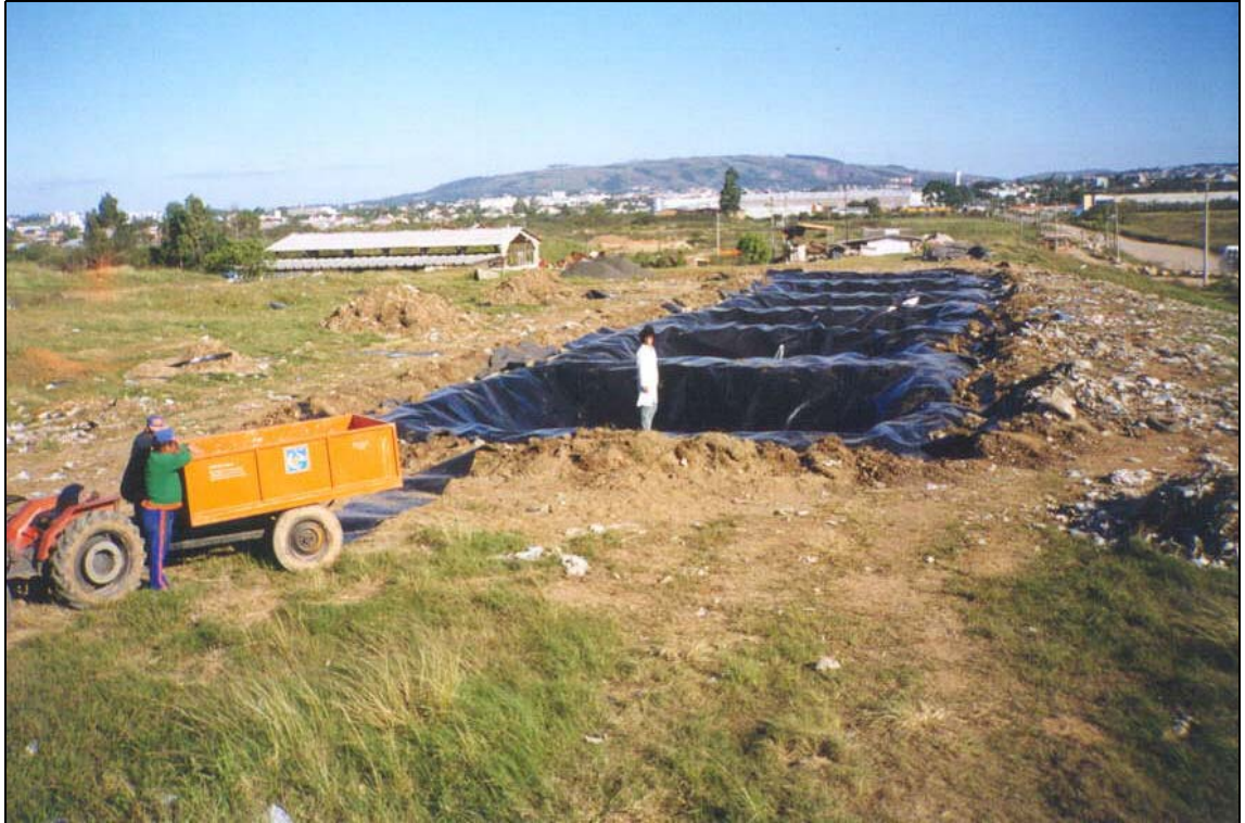
Figura C12 – Vista do conjunto das células C1 a C6, recobertas por PEAD (2 mm).
