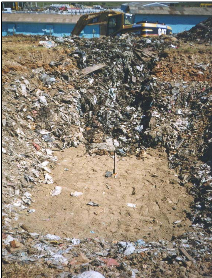
Figura C6 – Resíduo sendo recolocado na vala da célula C6. Detalhe do dreno de lixiviado no fundo da célula.
