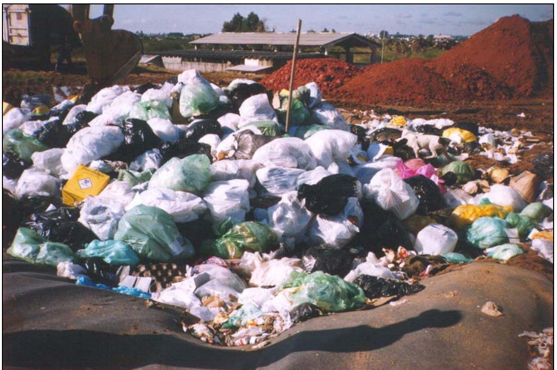
Figura C19 – Célula C6 com RSSS, aguardando cobertura de argila e detalhe do dreno de gás no centro da célula.
