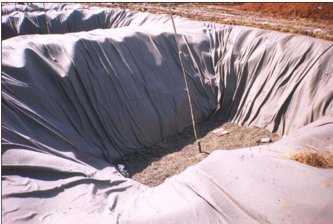
Figura C14 – Detalhe da camada de brita colocada sobre o fundo da célula, precedendo a colocação dos resíduos.
