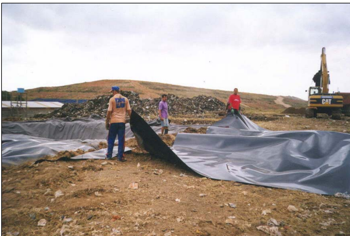
Figura C9 – Lâmina de PEAD (2 mm), sendo arrastada para cobrir célula.
