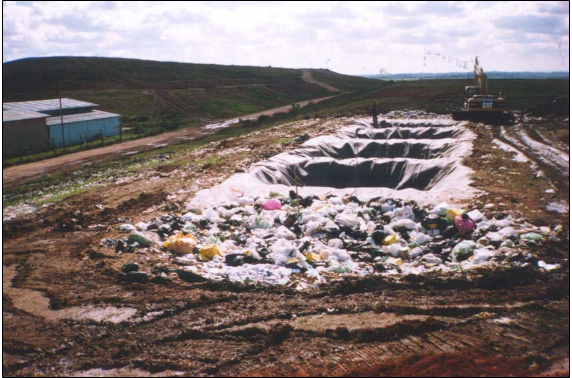
Figura C18 – Vista das células recobertas com BIDIM 180, com a célula C6 (à frente) contendo RSSS e a célula C1 (ao fundo) contendo RSU.
