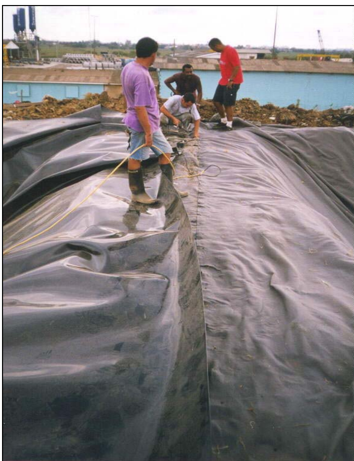
Figura C11 – Soldagem do BIDIM 400 sob manta de PEAD 2 mm.
