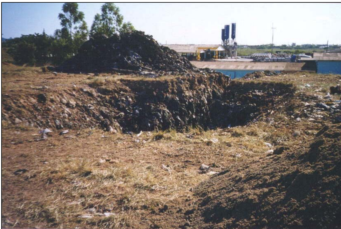
Figura C3 – Resíduo retirado da vala da célula C6, para ser recolocado posteriormente.
