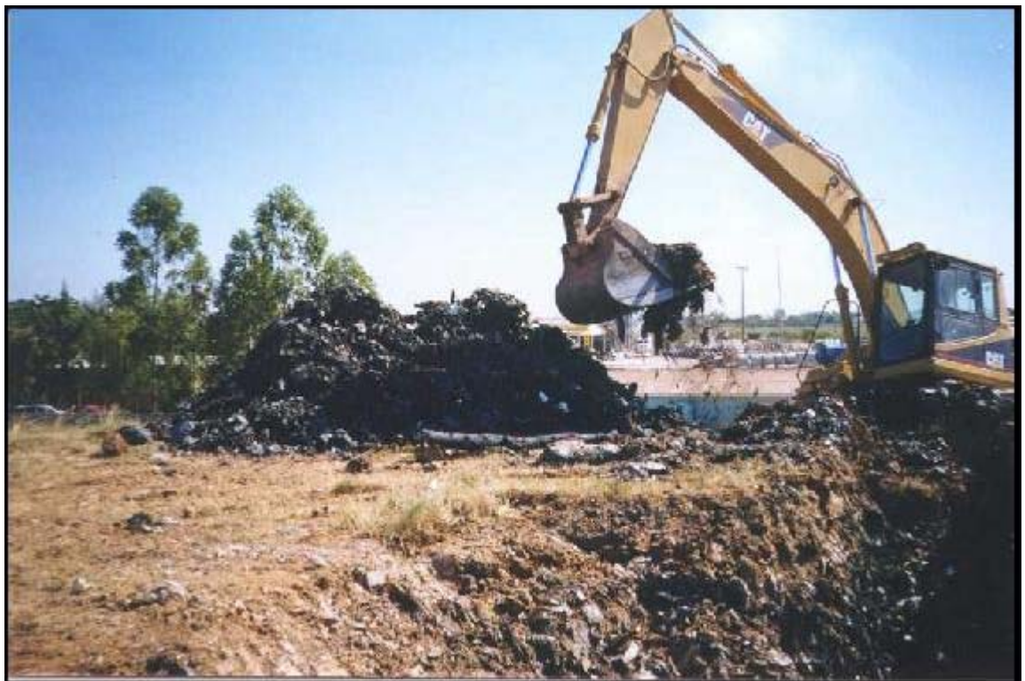
Figura C2 – Finalização da escavação da célula C6 e início da escavação da vala.
