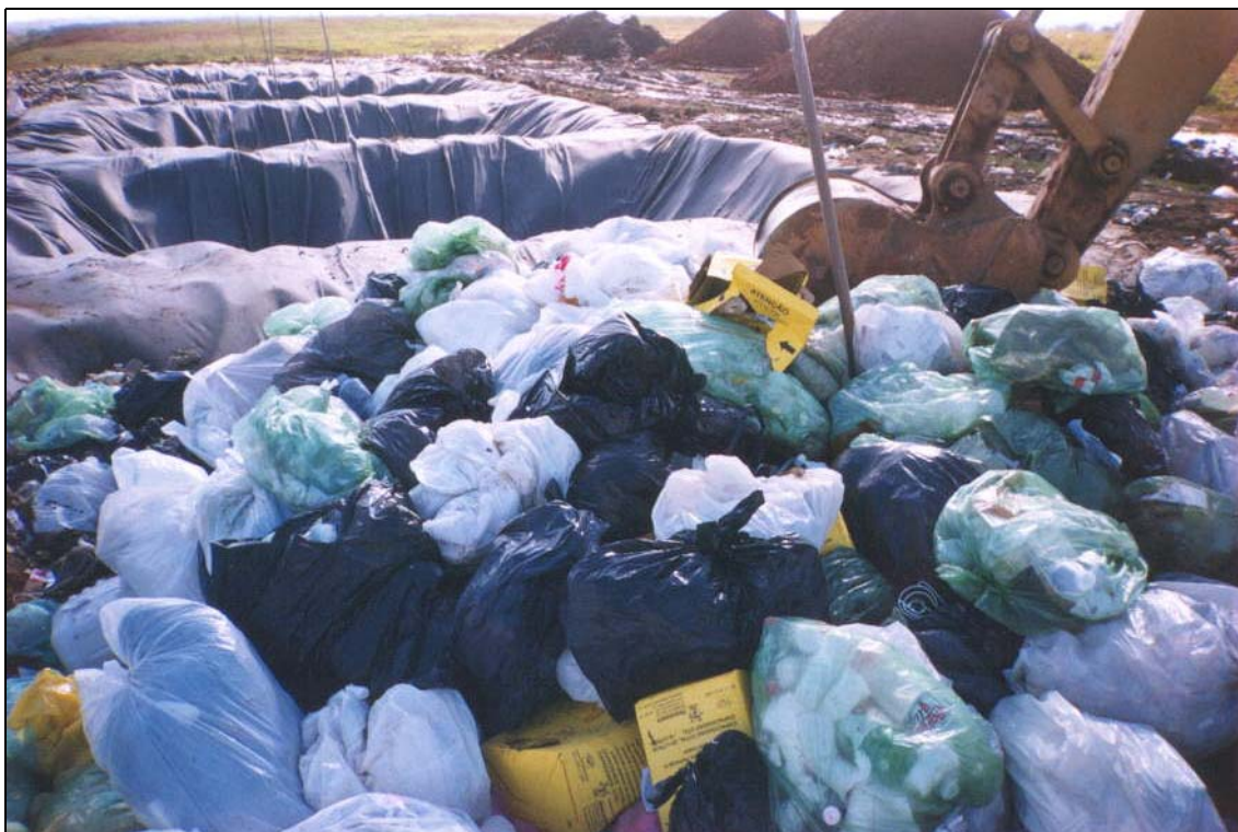
Figura C20 – Aspecto do RSSS disposto na célula C6. Retroscavadeira abrindo sacos e caixas amarelas de pérfuro-cortantes.
