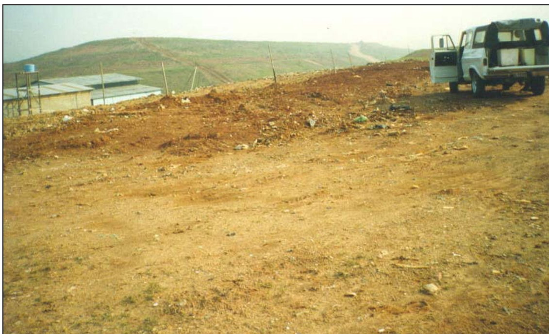
Figura C30 – Vista das células cobertas com argila compactada – final da montagem.
