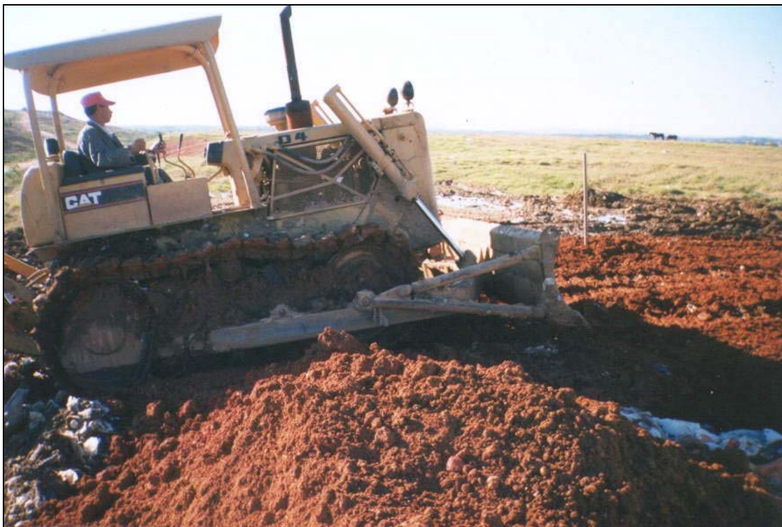
Figura C29 - Recobrimento das células com argila. Compactação adicional do resíduo.
