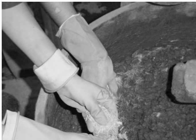
Figura 5.2 - Adição da fibra a mistura de concreto.
