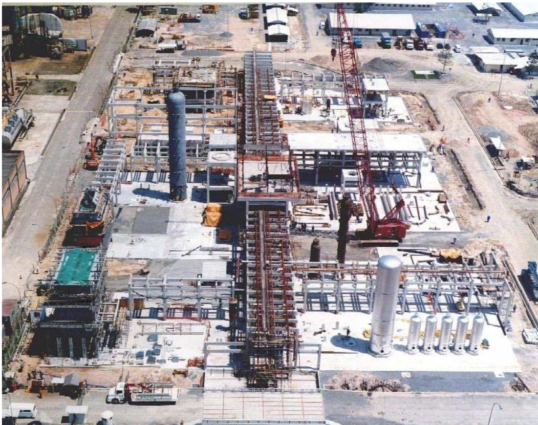
FIGURA 21 – Construção da Unidade de Hidrodessulfurização (HDS).
