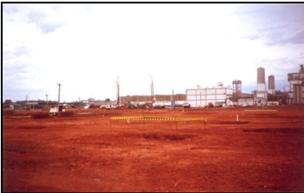
Figura 4.11 – Vista geral da obra de ampliação da planta petroquímica - Ipiranga Petroquímica
