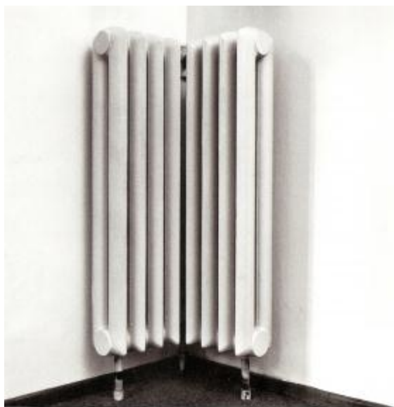
Figura 38 - Casa Wittgenstein - radiador de calefação da sala de desjejum projetado por Ludwig Wittgenstein. Fonte: Leitner (2000), página 169.
