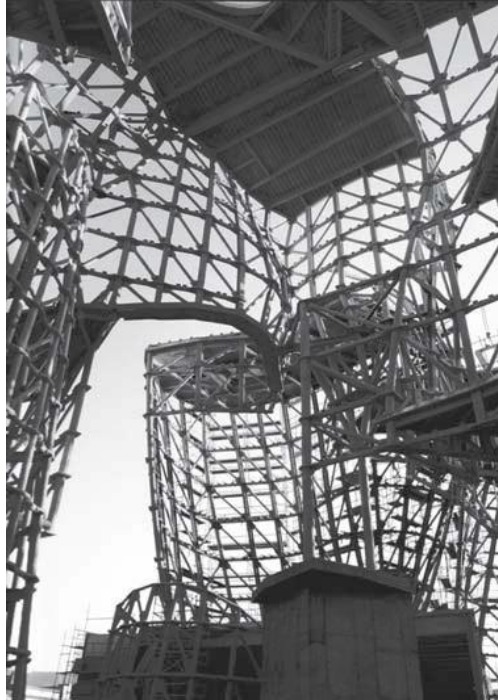
Figura 23: Museu Guggenheim Bilbao, Frank Gehry, 1997. Estrutura de aço, malha triangulada da forma externa do edifício. Fonte Andrea Deplazes (2005), página 118.
