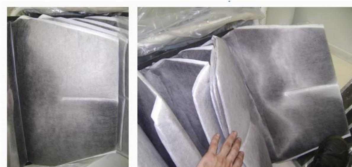
Figura 13 - Elementos filtrantes com retenção não-uniforme
