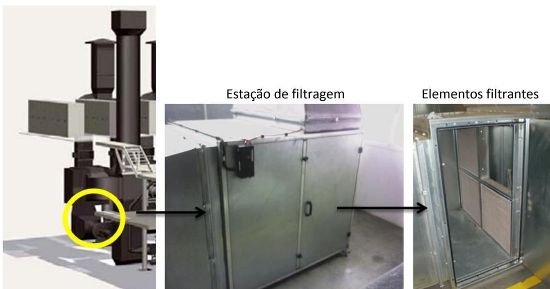
Figura 4 - Sistemas de ventilação de ar de processo e estações de filtração.
