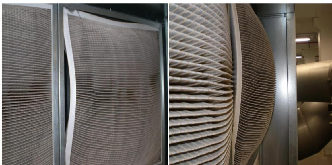
Figura 10 - Deformação estrutural dos elementos filtrantes decorrente de saturação
