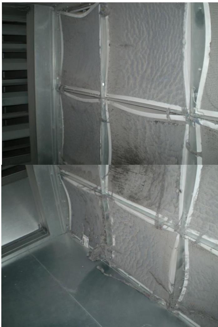
Figura 9 - Bloqueio da malha filtrante decorrente de saturação
