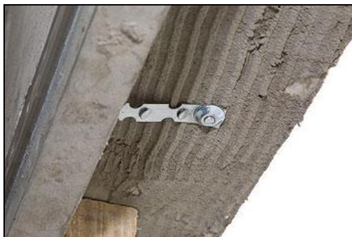
Figura 8: chumbamento do contramarco (INSTALAÇÃO..., 2010a, p. 17)
