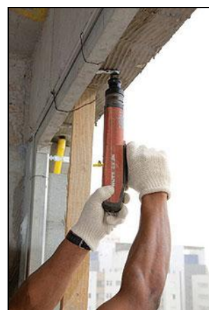
Figura 7: instalação do contramarco (INSTALAÇÃO..., 2010a, p. 16)
