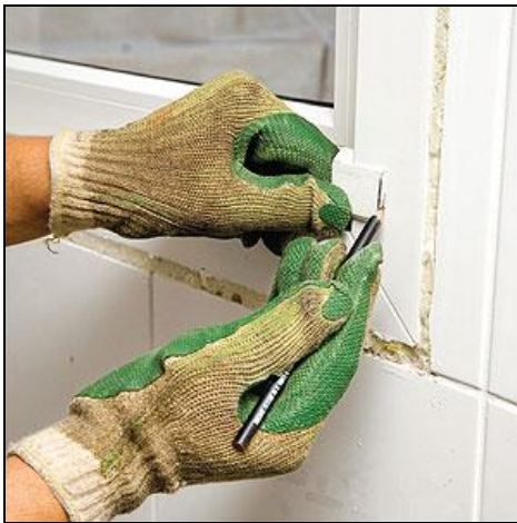
Figura 16: instalação dos perfis de arremate (INSTALAÇÃO..., 2010b, p. 21)
