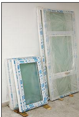
Figura 11: recebimento e armazenagem de esquadrias de PVC (INSTALAÇÃO..., 2010b, p. 20)
