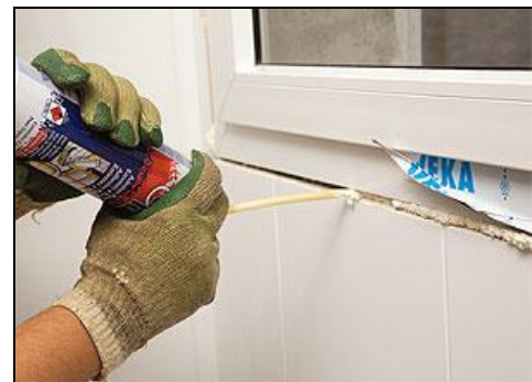
Figura 15: preenchimento com espuma de poliuretano (INSTALAÇÃO..., 2010b, p. 21)
