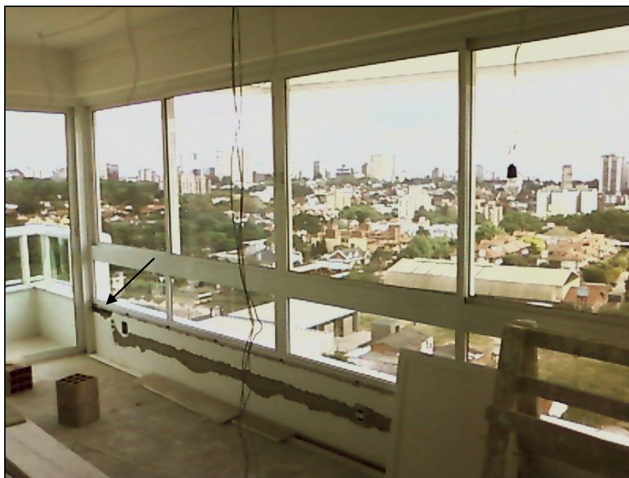
Figura 31: janela de correr de alumínio quando já iniciados os reparos
