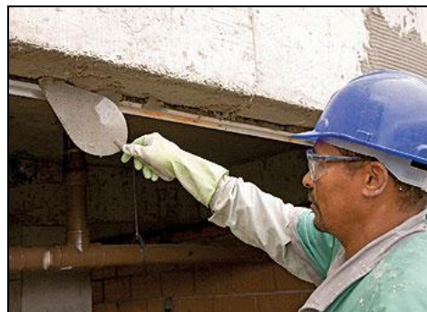
Figura 9: preparação para instalação da esquadria (INSTALAÇÃO..., 2010a, p. 17)
