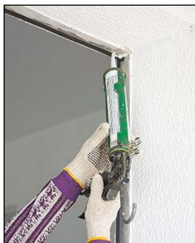
Figura 10: arremates e finalização (INSTALAÇÃO..., 2010a, p. 17.)
