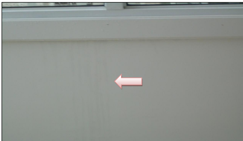
Figura 21: detalhe do escoamento d'água 17
