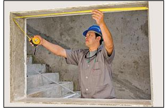
Figura 13: conferência das medidas do vão (INSTALAÇÃO..., 2010b, p. 20)
