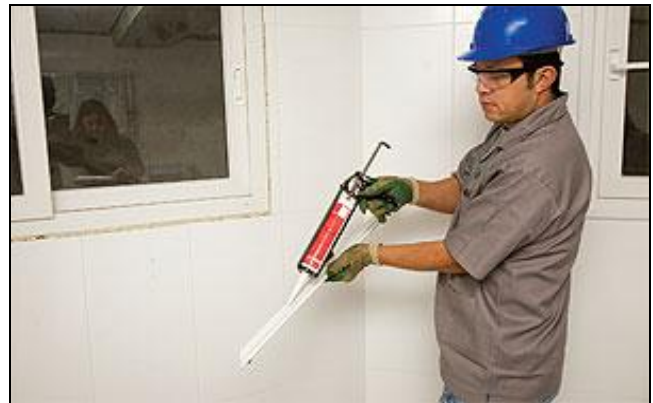
Figura 17: aplicação de silicone (INSTALAÇÃO..., 2010b, p. 21)
