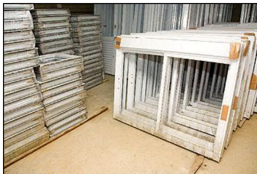
Figura 5: armazenagem das esquadrias de alumínio (INSTALAÇÃO..., 2010a, p. 16)
