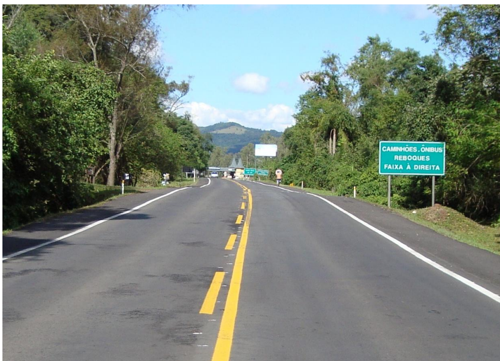
Figura 13: desníveis e mudança do traçado da rodovia devido aos deslocamentos
