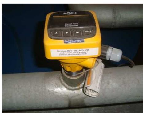
Figura 25: medidor microturbina
