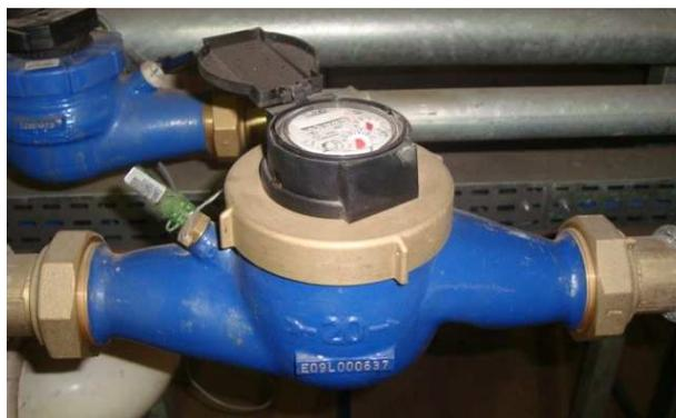
Figura 23: hidrômetro velocimétrico
