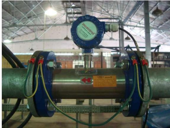
Figura 26: medidor turbina intrusiva seção plena
