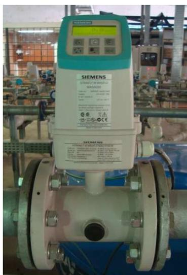
Figura 24: medidor de vazão eletromagnético
