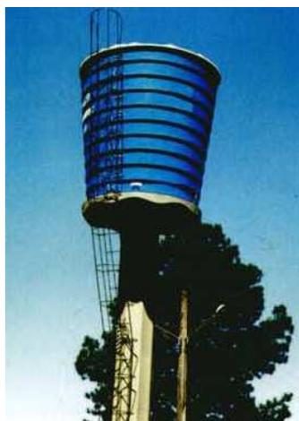
Figura 7: reservatório fabricado em fibra de vidro (LEAL, 2003, p. 57)
