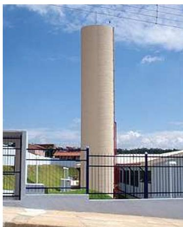
Figura 9: reservatório de concreto armado cilíndrico moldado *in loco* (NÁRLIR, 2011, p. 57)
