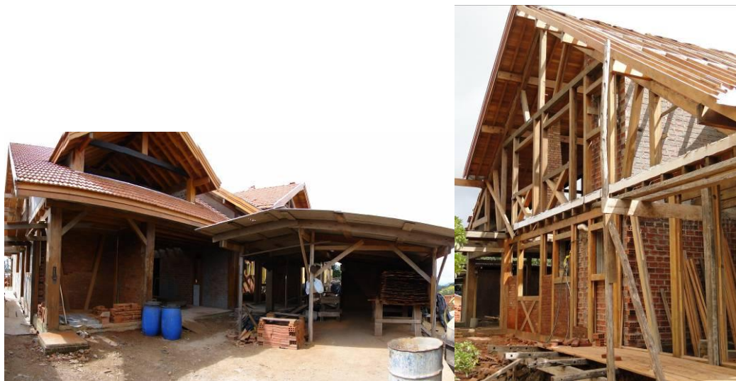
Figura 19: galpão de preparo da madeira e madeiramento 11
