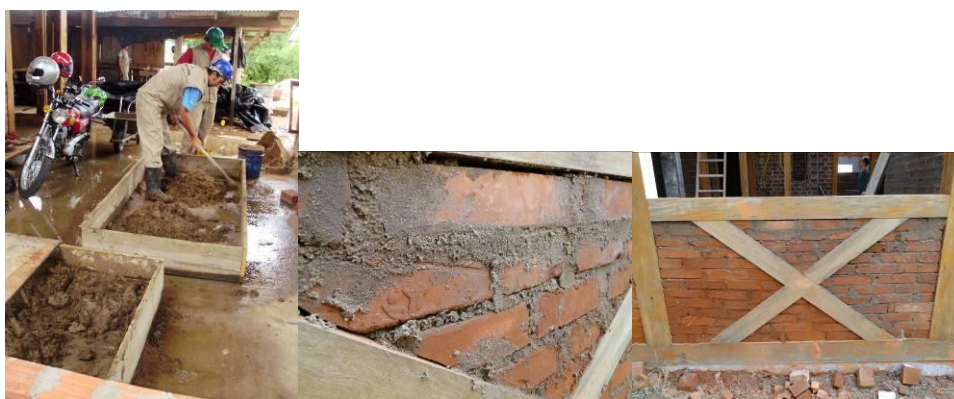
Figura 25: argamassa, preparo e assentamento 17
