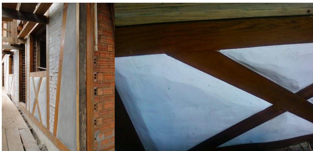
Figura 28: detalhe do reboco almofadado areia/cal 19
