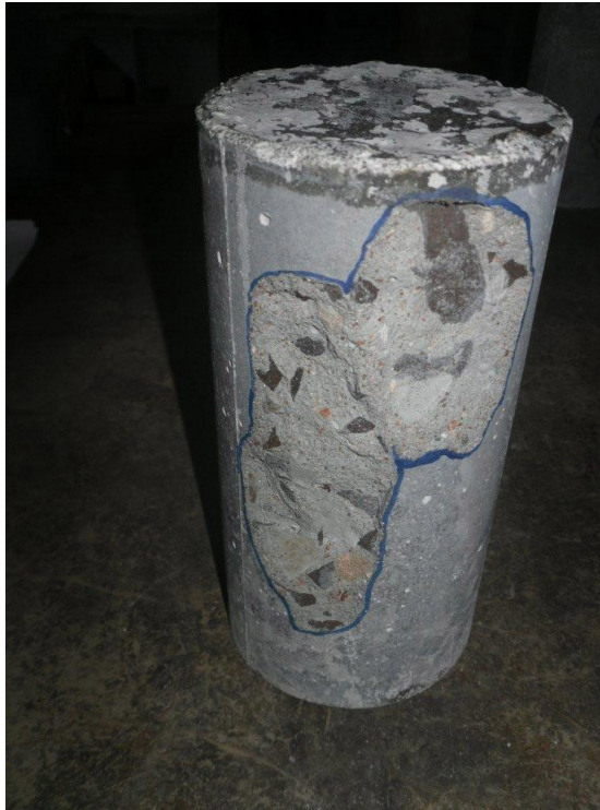
Figura 28: CP com ocorrência de spalling
