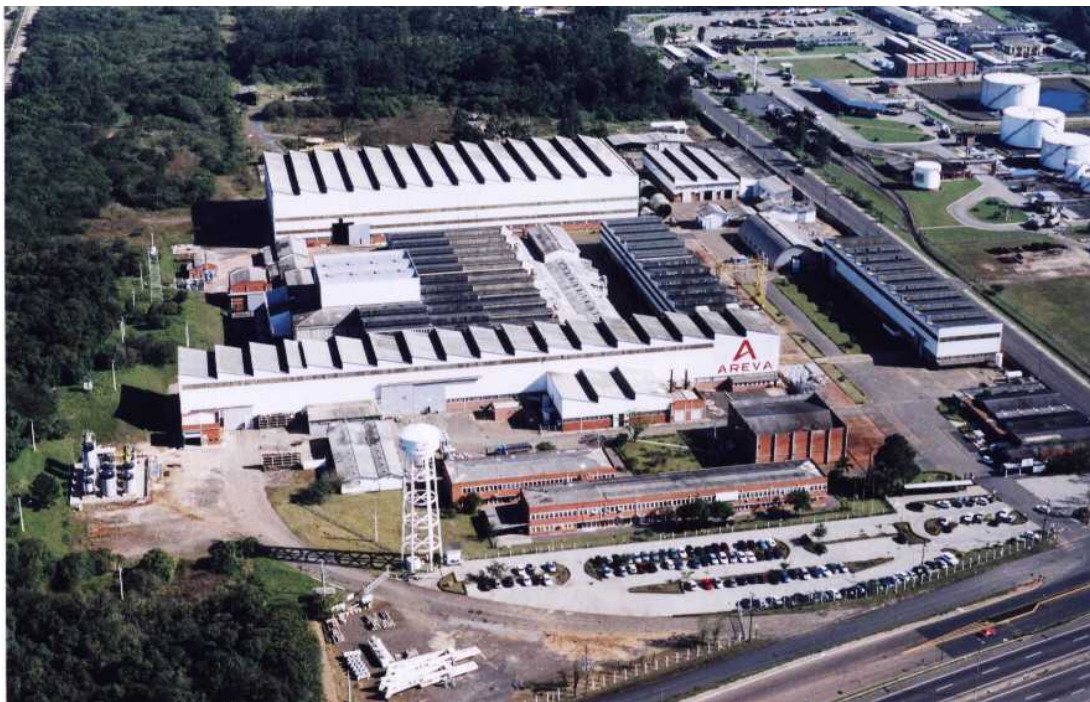
Figura 2: Unidade TCT, em Canoas Fonte: ALSTOM GRID Brasil
