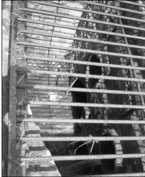
Figura 4.10: Detalhe da drenagem canalizada no trecho central da bacia.
