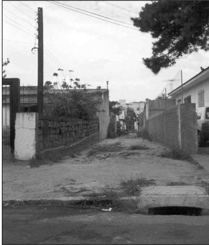
Figura 4.16: Vista do arroio canalizado e coberto, sendo seu uso destinado a passagem de pedestres neste trecho.
