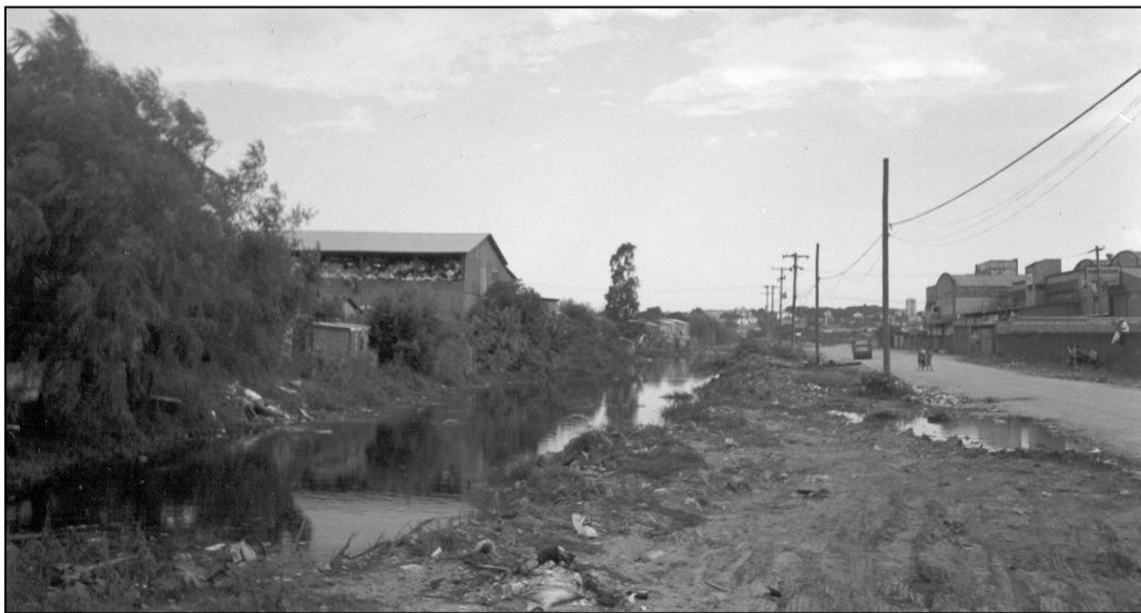
Figura 4.20: Drenagem da área à jusante da bacia, ao lado da Vila Dique. O arroio é drenado sobre um conduto forçado aberto (dique).
