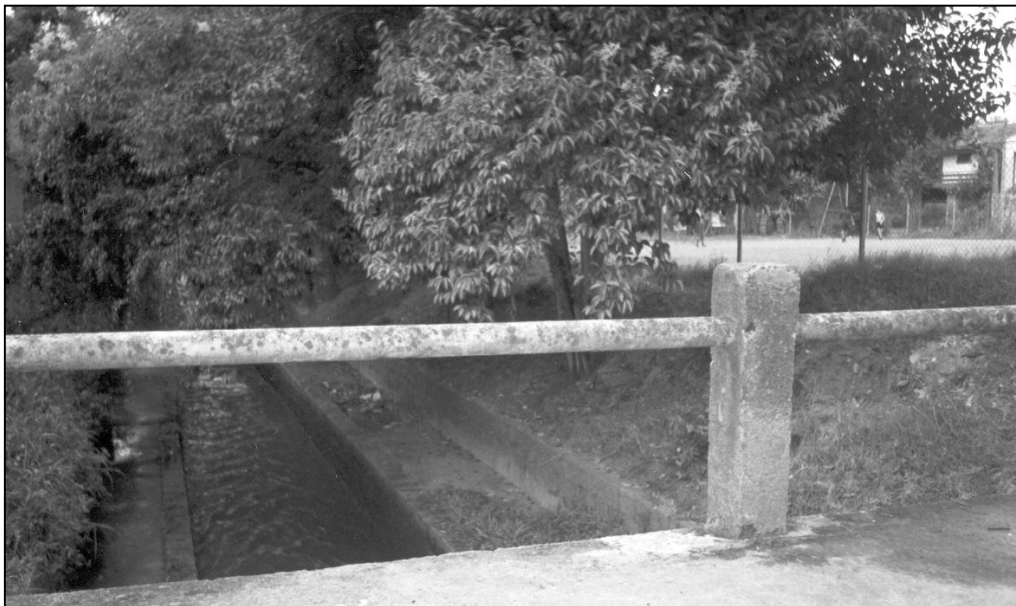
Figura 4.17: Outra vista do mesmo trecho do arroio também canalizado, porém, aberto.
