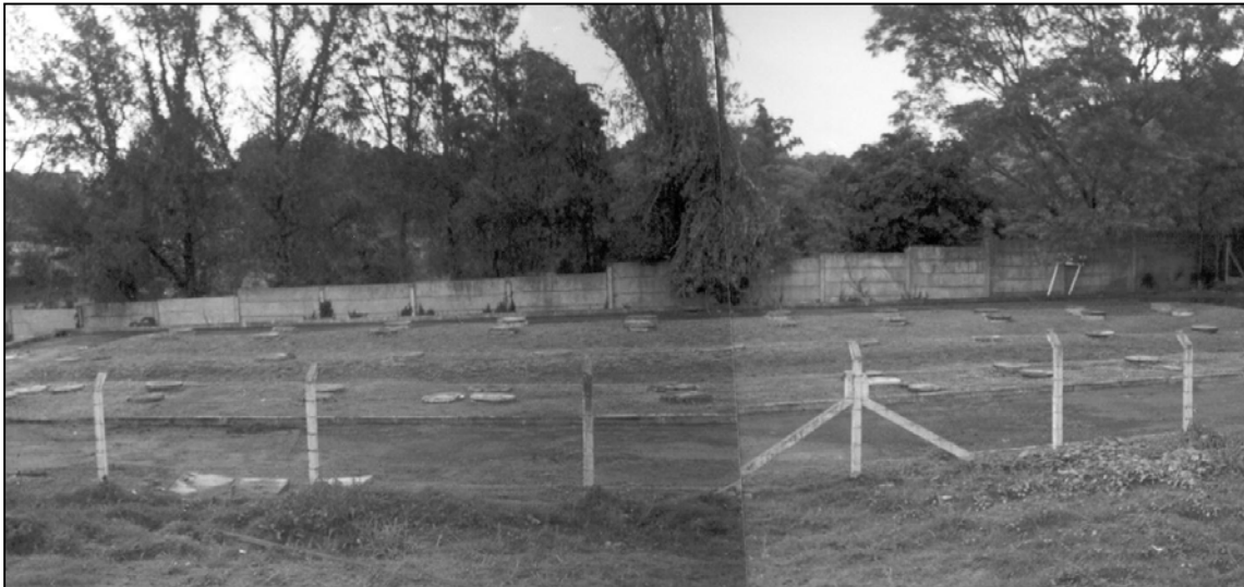
Figura 4.14: Estação de tratamento de esgotos do Shopping Center Iguatemi.
