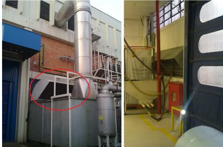
Figura 14: Esquerda: Fan coil com sua admissão de ar externa. Direita: Admissão de ar interna.
