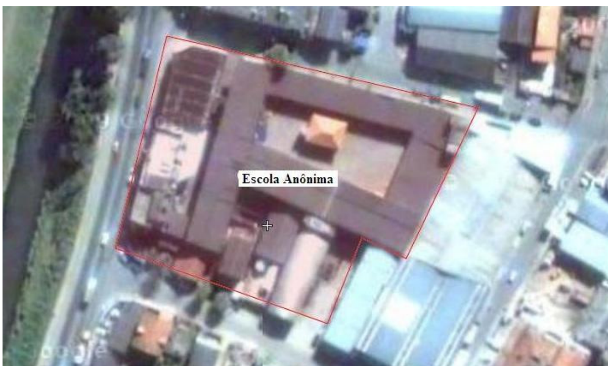
Vista Aérea da Escola Anônima.[8]
