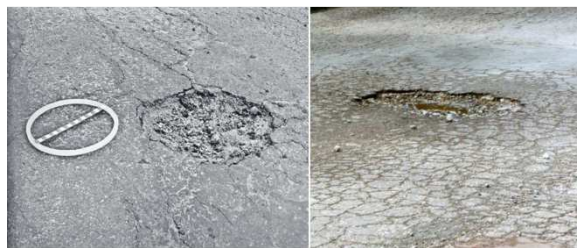
Figura I-2 - Foto de Panela ou Buraco (P)
