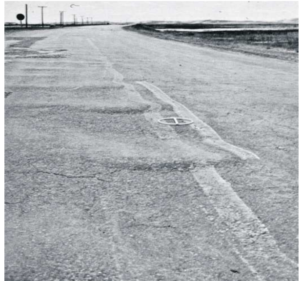
Figura I-5 - Foto de Corrugação ou ondulação (O)
