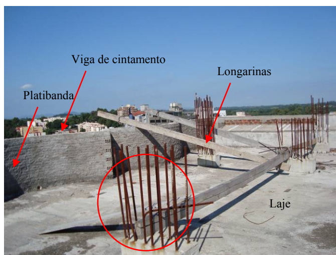
Figura 57: Detalhe das armaduras e apoio das longarinas
