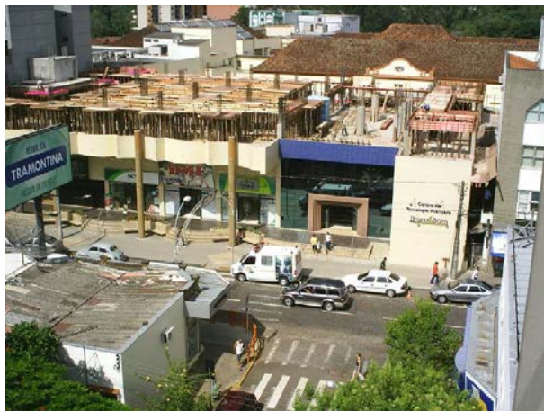
Figura 49: Montagem da 4ª laje
