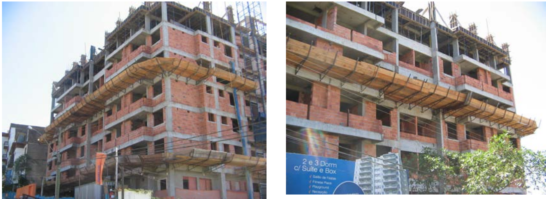
Figura 38: Empreendimento A na fase da aplicação do PISP
