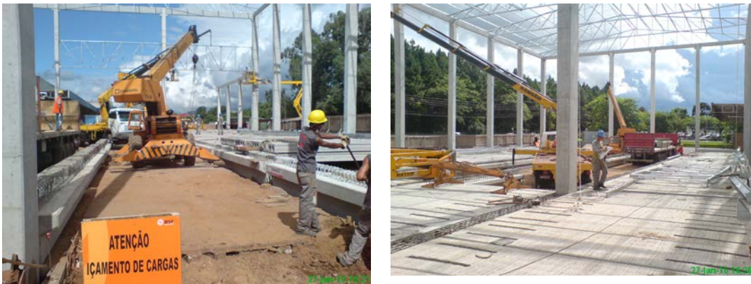
Figura 41: Fotografia do Empreendimento B já fase de execução em 22/01/2010
