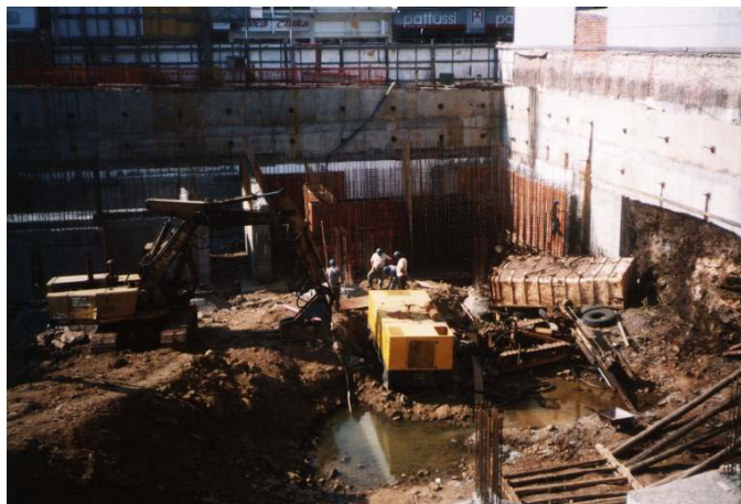
Figura 47: Escavação do subsolo
