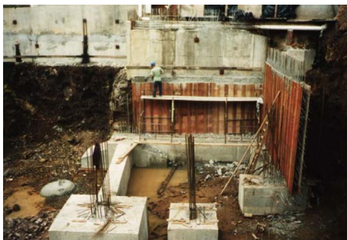
Figura 48: Blocos da fundação
