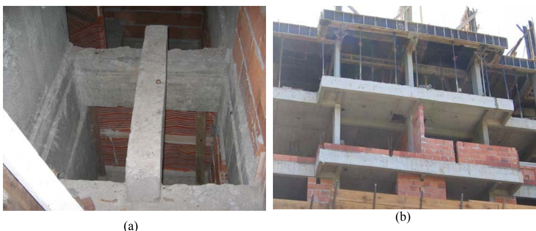
Figura 82: (a) Detalhe do shaft e (b) sacadas
