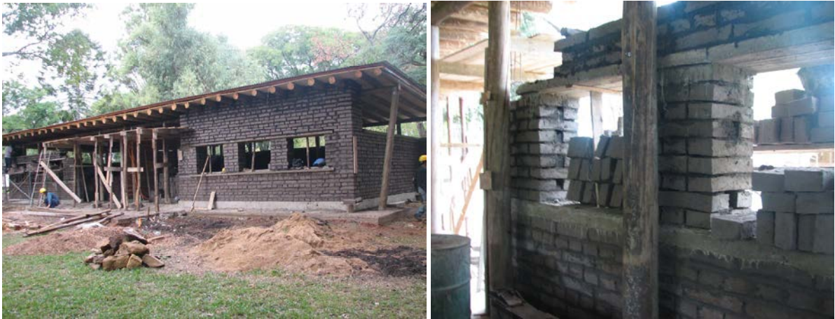
Figura 26: (a) vista externa de alvenaria de BTC, sem revestimento, em salas de aula – San António, Salto; (b) vista interna das salas de aula em construção, demonstrando a utilização de peitoris de concreto.
