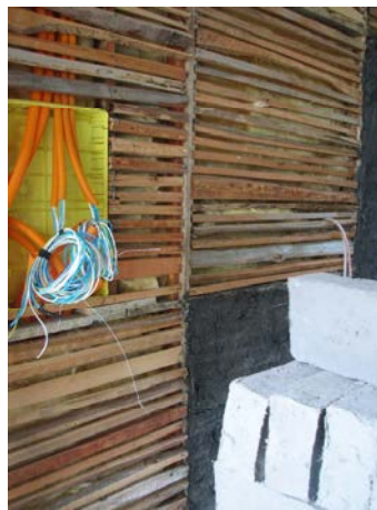
Figura 55: tubulação elétrica inserida entre duas faces da parede, preenchida com poliestireno expandido.
