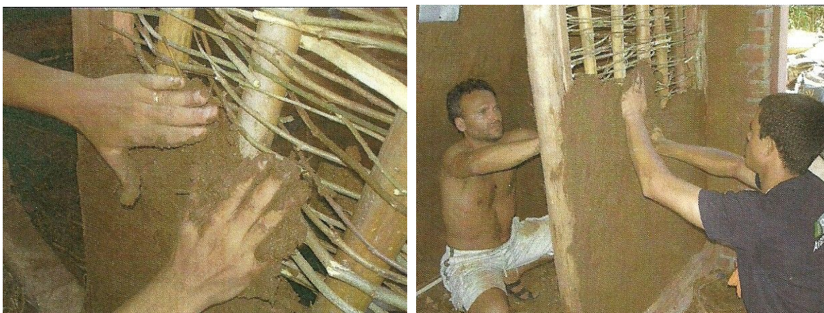
Figura 45: aplicação de terra sobre estrutura em pau-a-pique, combinando bambu e galhos tramados. Fonte: Integria.
