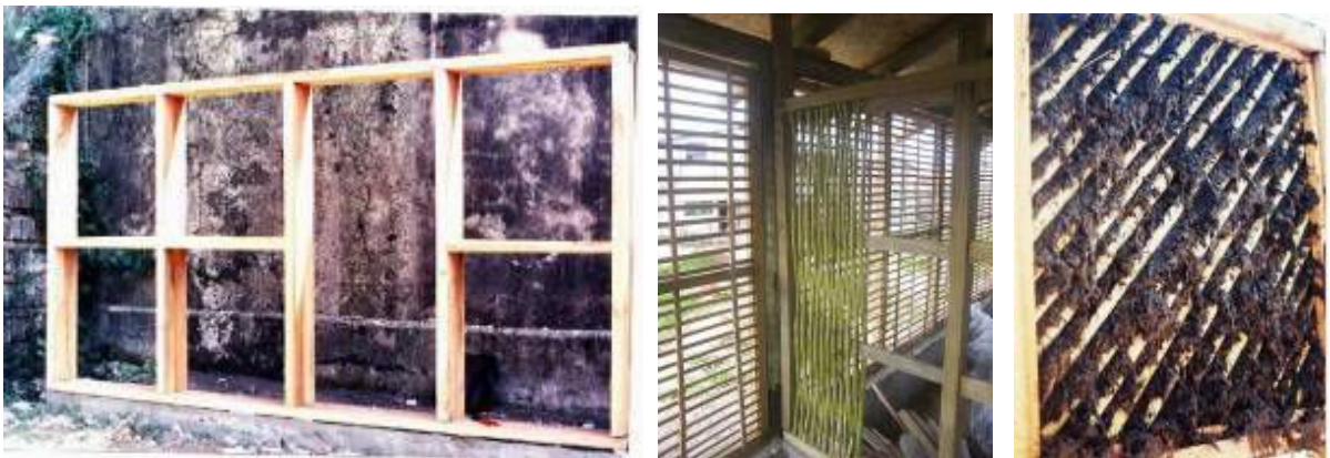
Figura 32: estrutura de pau-a-pique, ou taipa de mão, com trama de taquaras encaixadas e amostra de barreamento, sobre trama em diagonal. Fonte: Etchebarne et. al. (2006).
