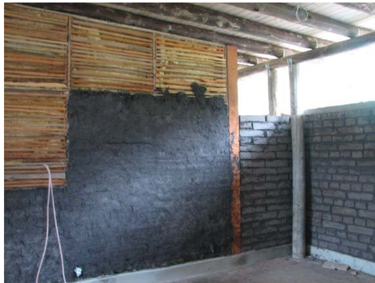
Figura 30: parede divisória em taipa de mão, salas de aula – San António, Salto.
