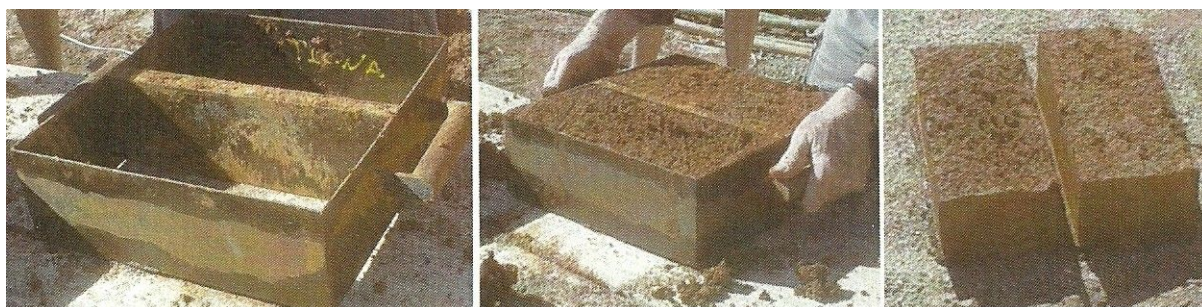
Figura 44: fôrmas metálicas duplas, também aplicadas na Fazenda Capão Alto das Criúvas. Fonte: Daudt (2006).
