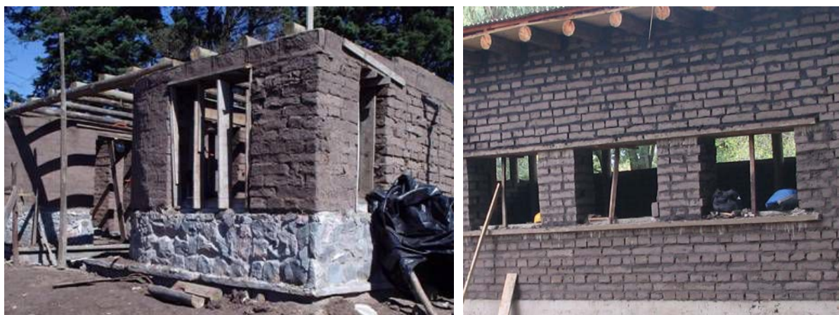
Figura 51: (a) construção de residência em adobe, na Cooperativa de Viviendas Guyunusa , em Solymer - Uruguai; (b) Aulário em San Antônio , Salto – Uruguai, edificado em adobes. Fonte: 51a – UREGH (2005).
