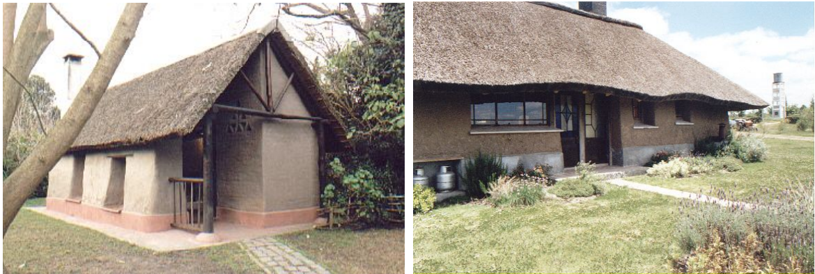
Figura 33: residências em terra edificadas com a utilização da técnica de torrões, respectivamente, Flia. Montero , em Montevideu e Flia. Weiss , em Maldonado. Fonte: Alderton (2003).
