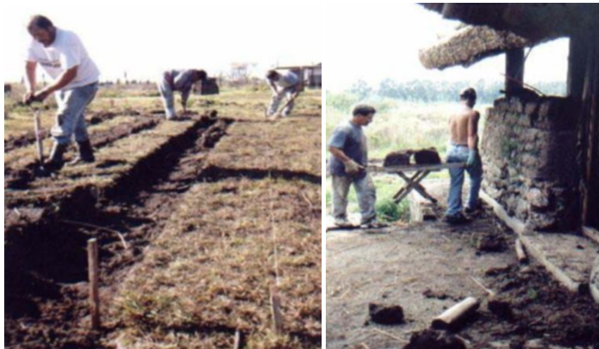
Figura 18: corte, extração e transporte de torrões (ALDERTON, 2003, p. 04).
