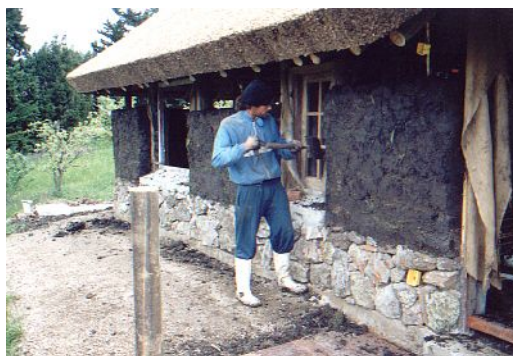
Figura 60: ajuste do nível e do prumo, com auxílio de pá. Fonte: Alderton (2003).
