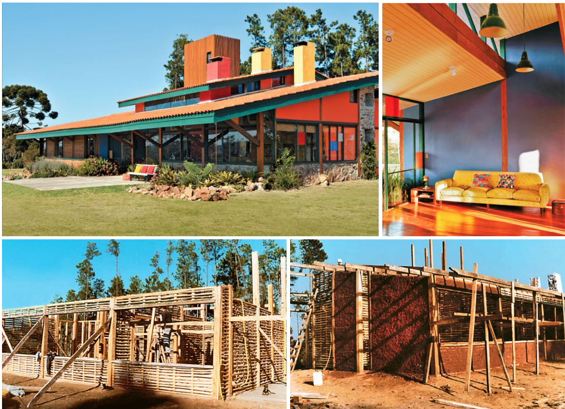
Figura 11: residência em pau-a-pique, construída em São Bento do Sapucaí, São Paulo. Fonte: Revista Arquitetura & Construção, Out/2008.
