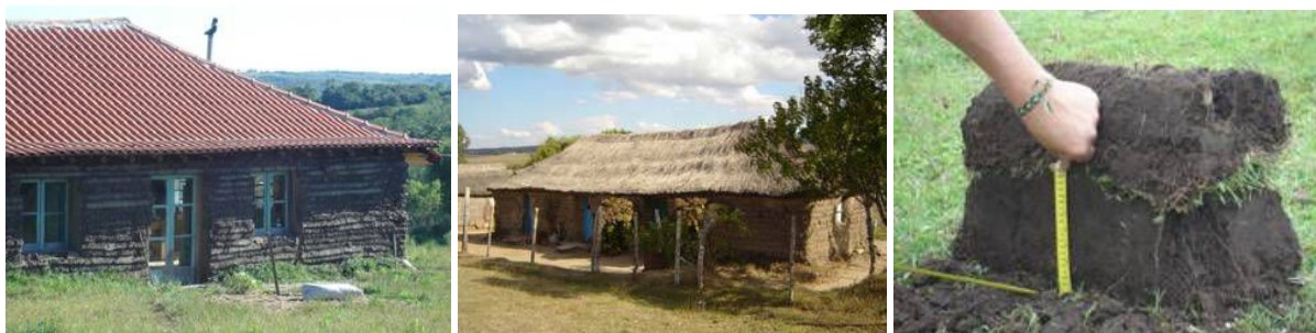
Figura 41: casa em superadobe, rancho tradicional da região e torrão de leiva de grama local. Fonte: PRUDENTE et. al. (2009).
