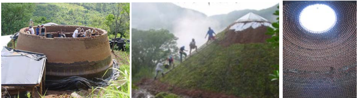
Figura 39: construção da cúpula de adobes do Centro de Vivências Integria, em Picada Café e visualização interna em direção à zenital. Fonte: Integria.
