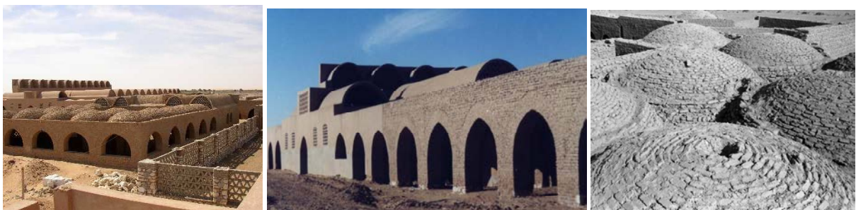
Figura 14: New Barris Village , em Kharga – Egito, construída com tijolos de adobe, por Hassan Fathy, em 1967. Fonte: http://www.pushpullbar.com/forums/showthread.php?8829-Egypt-Hassan-Fathi .
