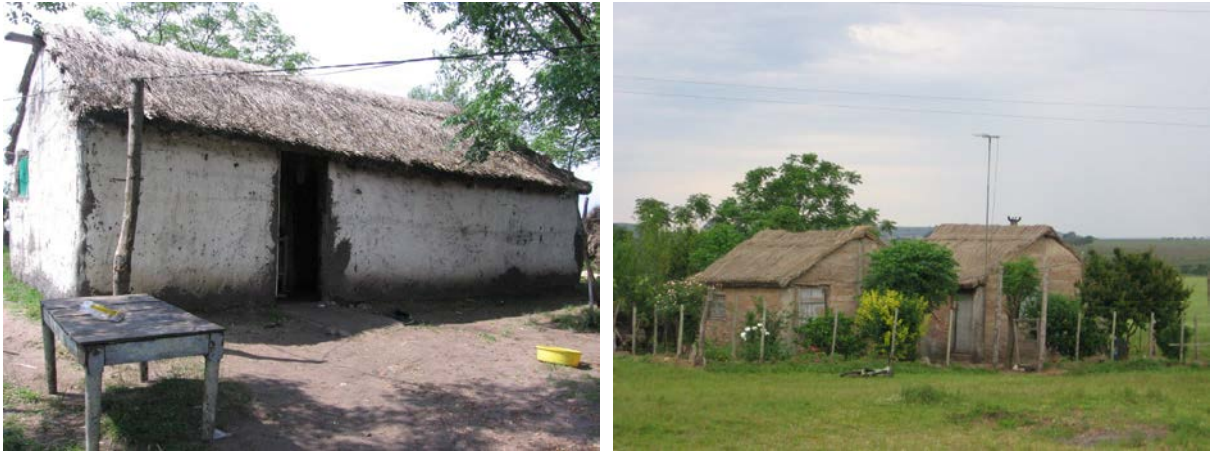
Figura 22: edificações no povoado de Ceballos (Fotos: Alejandro Ferrero, 2007).
