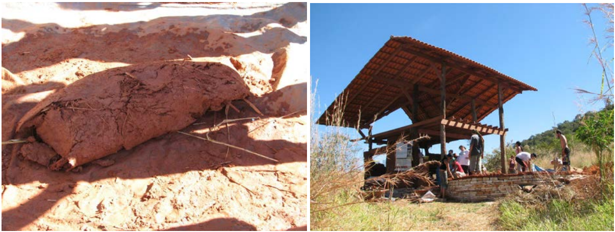
Figura 10: rolo de cob e edificação de dois pavimentos, sendo construída no Ecocentro IPEC, durante o Bioconstruindo 2008.
