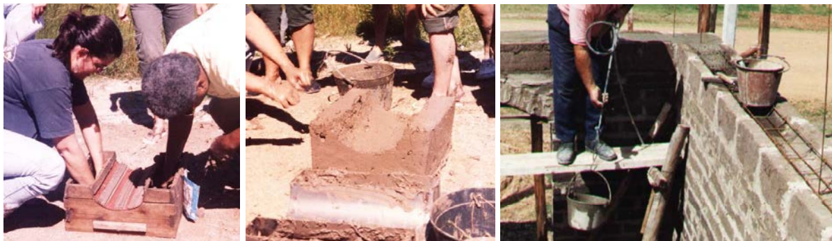
Figura 52: fabricação e emprego de tijolos de adobe curvos. Fonte: Etchebarne (2003)
