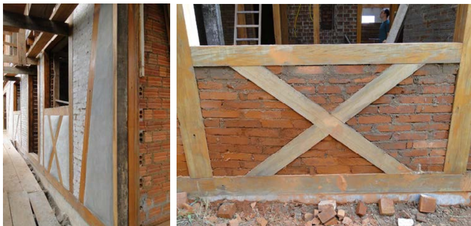
Figura 47: construção em estilo enxaimel, com tijolos assentados com argamassa de barro. Fonte: Juliana Moehlecke.
