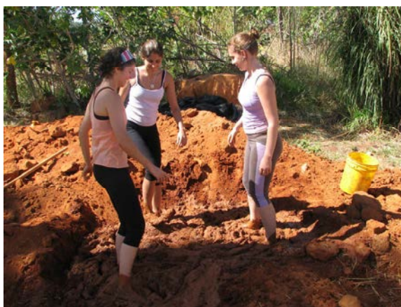
Figura 49: amassamento da mescla para fabricação dos tijolos de adobe durante o Bioconstruindo 2008, no Ecocentro, IPEC - GO.
