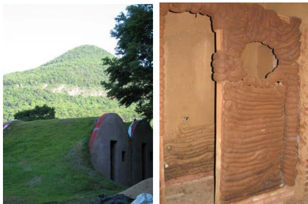
Figura 40: cabanas conjugadas, em forma de abóbodas, edificadas em adobe e com tratamento de mangueiras de terra no interior.
