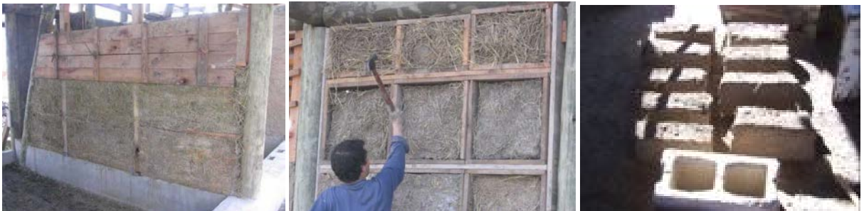
Figura 29: formas de utilização da técnica de terra-palha no Uruguai, respectivamente: taipa, painéis e blocos. Fonte: www.proyecto-hornero.edu.uy/proyecto.htm .
