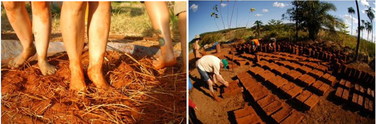
Figura 25: pisadeiro, onde é preparada a argamassa que originará os tijolos de adobe; e os mesmos sendo desformados, aguardando secagem ao sol. Fonte: Ecocentro – IPEC.
