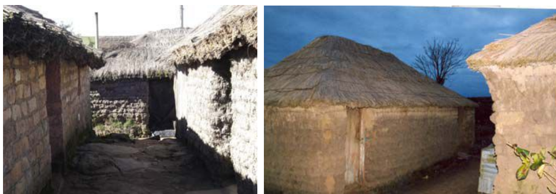
Figura 37: ranchos de torrão em Aceguá, região fronteira com o Uruguai. Fonte: Morgado e Costa (2003).
