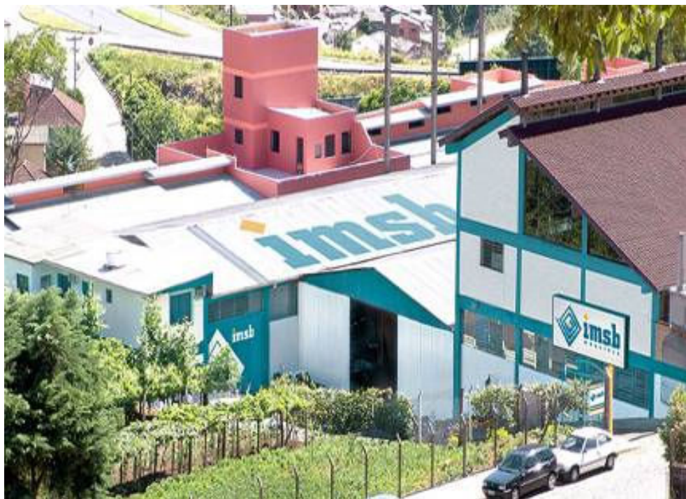
Figura 3 - Vista parcial da empresa Fonte: Arquivos internos da empresa
