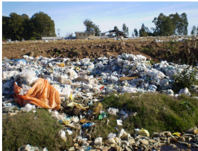
Figura 8: Vala com resíduos esperando camada de terra.
