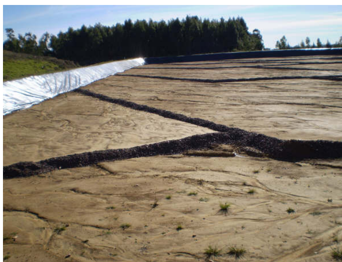
Figura 6: Célula inicial do Aterro Sanitário
