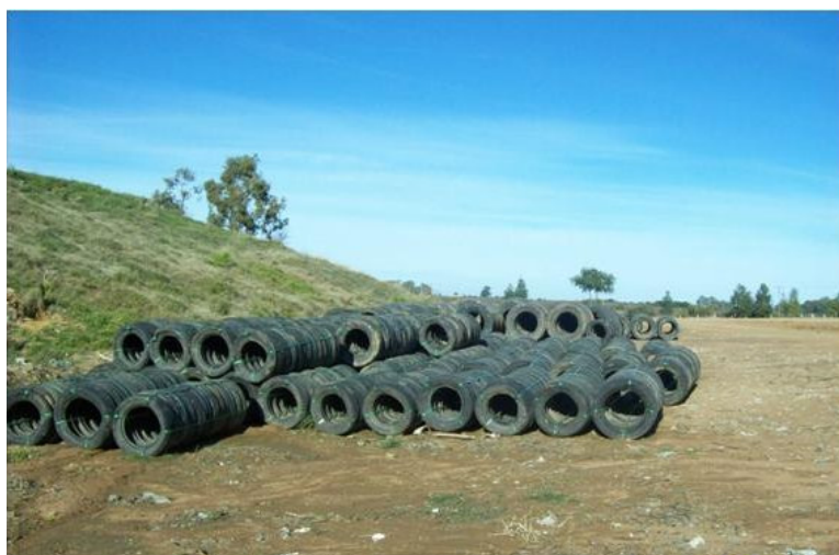
Figura 9: Pneus que serão utilizados para construção de bueiros
