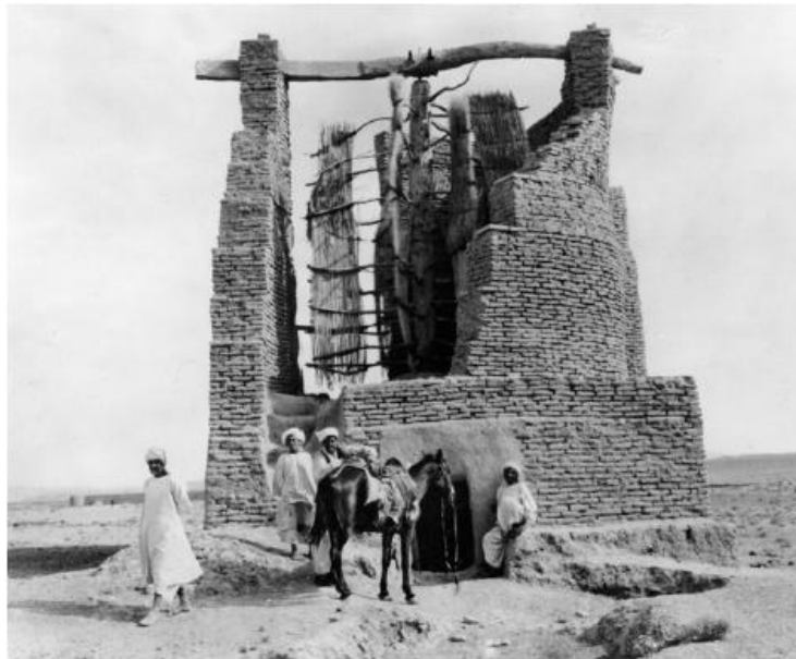
Figura 2.1 – Moinho de eixo vertical para moagem de grãos no Afeganistão [Hau, 2006]
