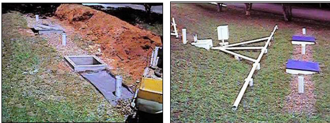
Figura 3.23 –Trincheira II: fechamento e pronta para o monitoramento
