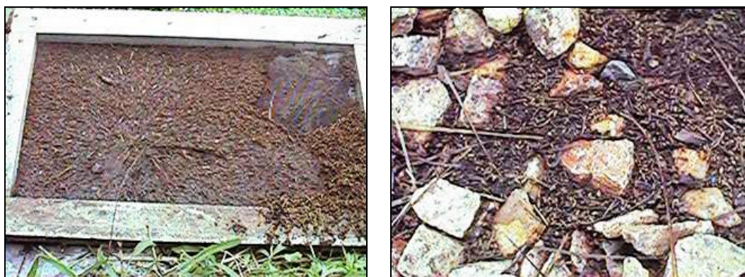
Figura 4.19– (a) tela da caixa de areia entupida e (b) material em suspensão colmatando primeira camada da trincheira
