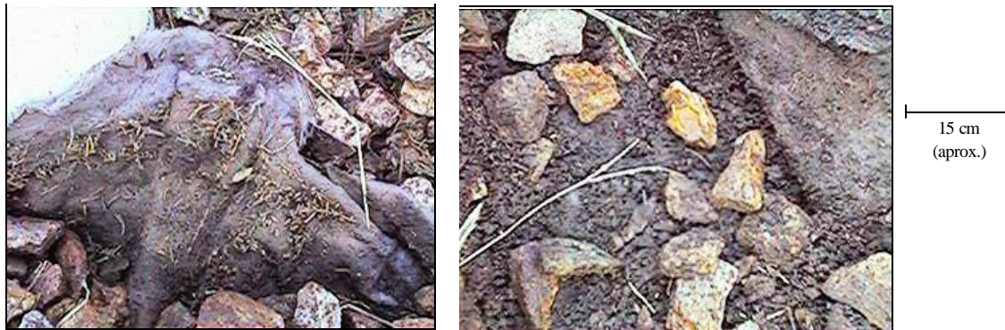
Figura 4.20 – Colmatação da camada superior da trincheira (geotêxtil)
