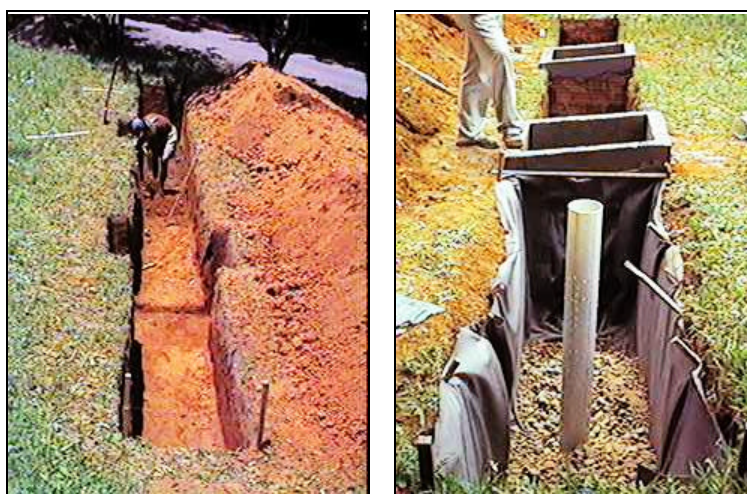
Figura 3.22 – Escavação e enchimento da trincheira
