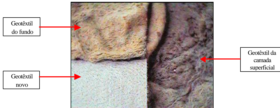
Figura 4.23 – Condições do geotêxtil no interior da trincheira
