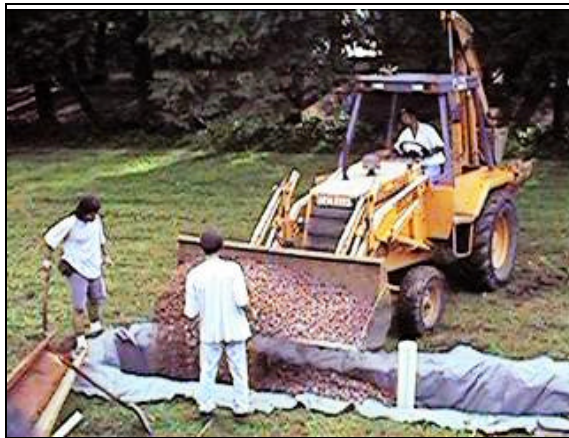
Figura 3.14 – (a) Escavação da trincheira e (b) colocação de bidim®
