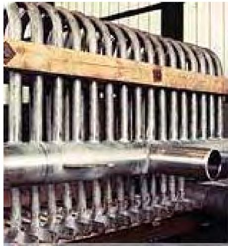
**Figura 20- Detalhe da serpentina do forno de pirólise de etileno de onde foram retiradas as amostras.**
