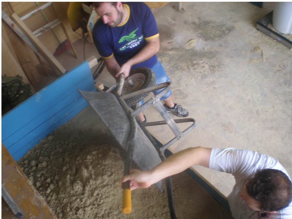
Figura 3.11: Colocação do material para dentro da caixa.
