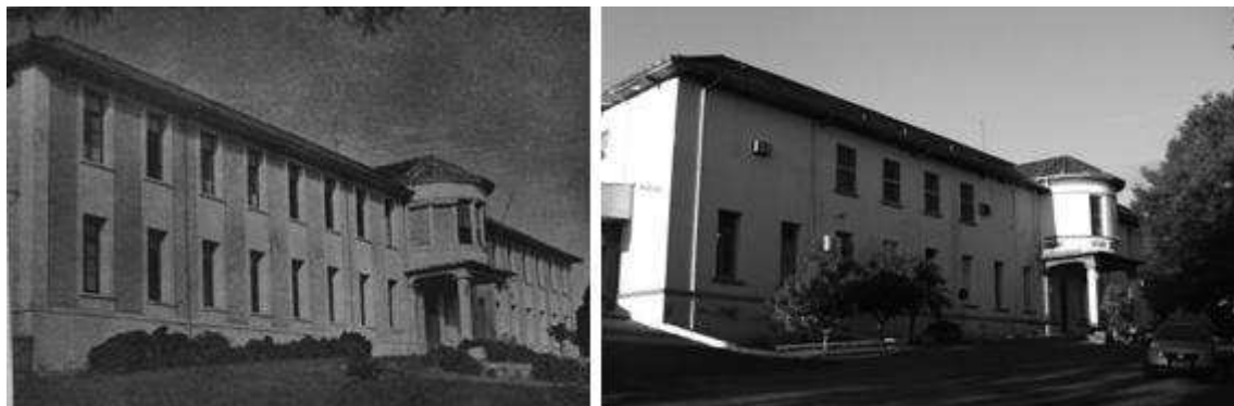
FIGURA 130 – O edifício da Casa de Saúde (prédio número 6 no mapa de Santa Maria). Fontes: CCEVFRGS. Meio século de atividades da Cooperativa de Consumo dos Empregados da Viação Férrea do Rio Grande do Sul Limitada, 1913-1963 – 50 anos . Santa Maria: Diretoria, 1963 e foto do autor (2010).
