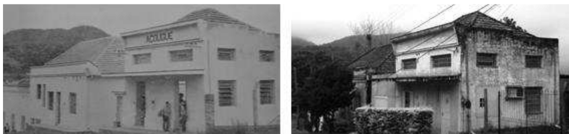
FIGURA 140 – Edifício do açougue e da padaria do Núcleo de Otávio Lima (n° 14 no mapa de SM). Fonte: CCEVFRGS. Relatório – Exercício de 1962 . Santa Maria, 1963 e foto do autor (2010).
