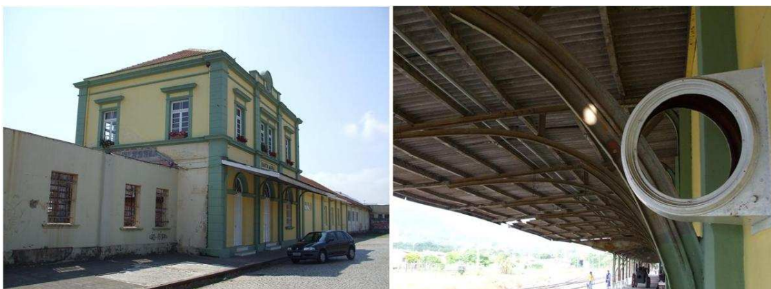
FIGURA 24 – Estação Férrea de Santa Maria e sua Gare em 2010: o relógio “roubado” como metáfora do tempo perdido. Fonte: fotos do autor, 2010.
