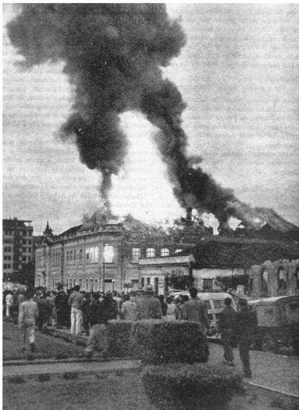
FIGURA 57 – Incêndio do edifício do internato da Escola de Artes e Ofícios em 1954. Fonte: CCEVFRGS. Resumo dos Empreendimentos. Visão retrospectiva – 1955 . Santa Maria: Diretoria, 1955.
