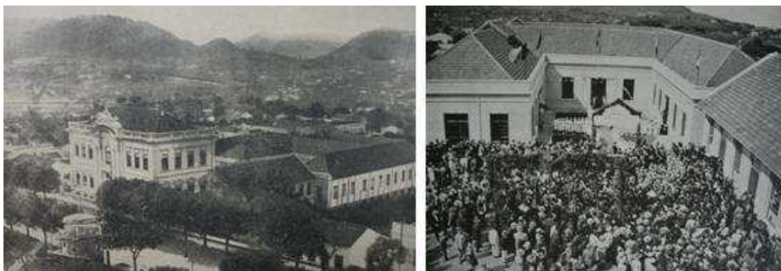
FIGURA 52 – Escola de Artes e Ofícios Hugo Taylor. Vista externa do conjunto e vista do pátio interno no dia da inauguração das Oficinas. Fonte: CCEVFRGS. Relatório de 1923 . Santa Maria: Diretoria, 1924 e CCEVFRGS. Relatório de 1925 . Santa Maria: Diretoria, 1926.
