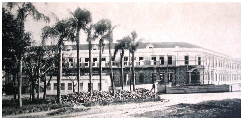
FIGURA 51 – Escola Santa Terezinha. Instalações antigas e edifício em construção (nº 12 no mapa de Santa Maria). Fonte: CCEVFRGS. Relatório – Exercício de 1928 . Santa Maria: Diretoria, 1929.
