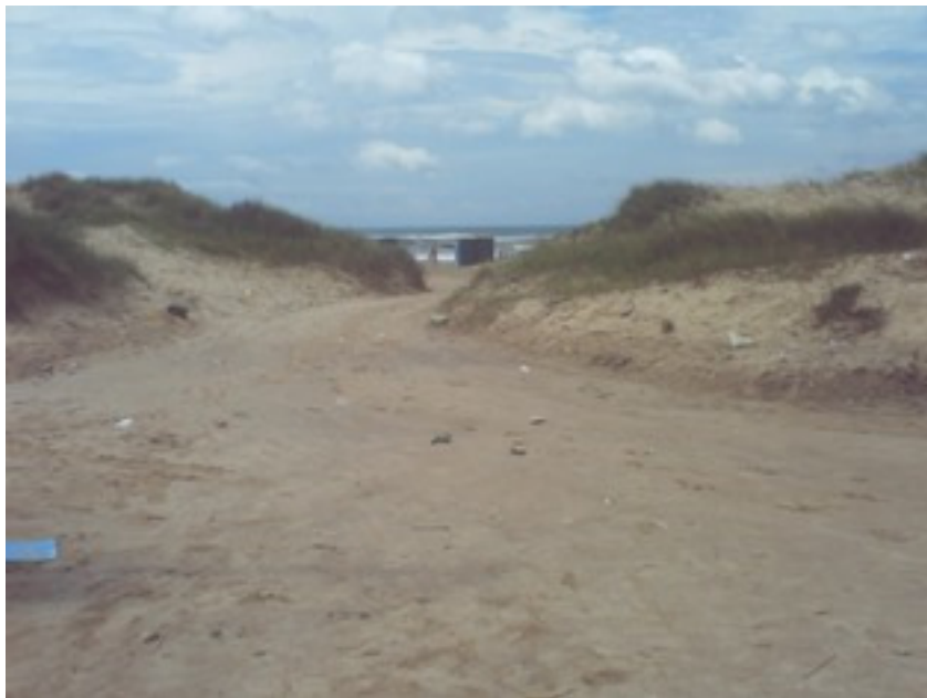
Foto 04 – Retirada das dunas no acesso ao mar (2010)
