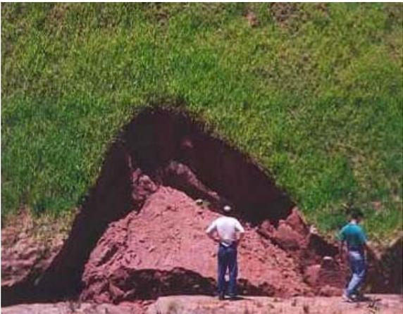
Foto 17 – Solapamento de base de talude por erosão junto ao pé (RS239)
