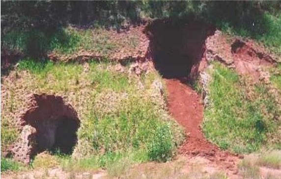
Foto 16 – Buracos por erosão interna na face de talude de corte (RS239)
