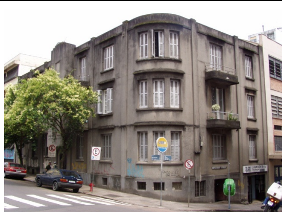
Imóvel R. Riachuelo antes da restauração
