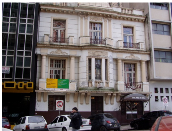
Hotel Praça da Matriz em restauração
