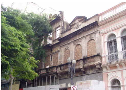
Imóvel à Rua dos Andradas 673 antes da restauração
