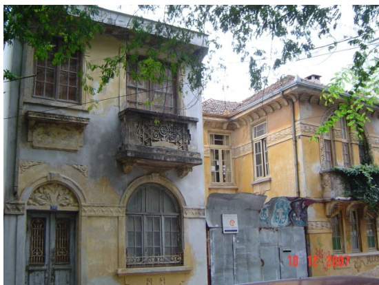
Imóvel R. Demétrio Ribeiro antes da restauração
