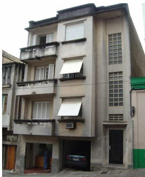
Imóvel R. João Manoel antes da restauração
