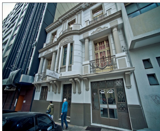
Hotel Praça da Matriz restaurado
