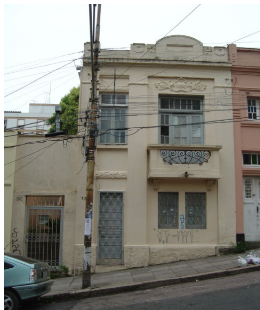
Imóvel Rua Gen Auto antes da restauração
