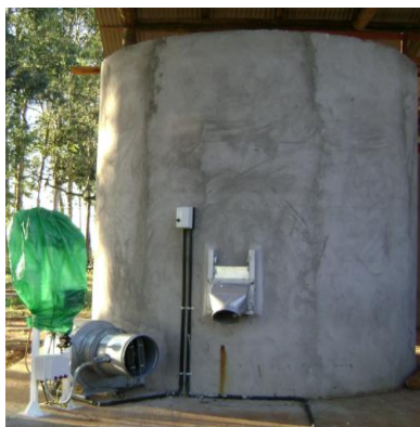
FIGURA 1. Silo-secador de concreto armado com capacidade para 100 sacos de milho. Eldorado do Sul, RS. 2010.
