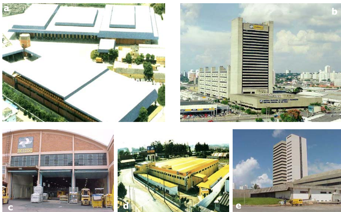
Figura 3.8 – Prédios que abrigam Centros de Triagem.
