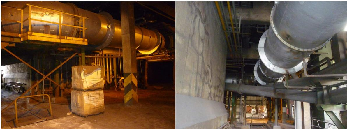
Figura 6 – Vista parcial dos dutos do despoeiramento após a câmara de combustão (Cortesia Gerdau Guaíra)
