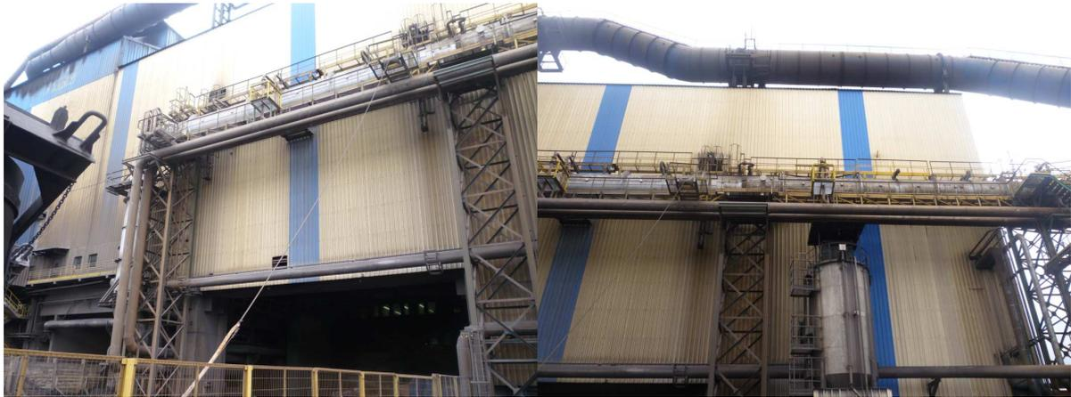
*Figura 11 – Dutos refrigerados do lado de fora da aciaria (Cortesia Gerdau Guaíra)*
