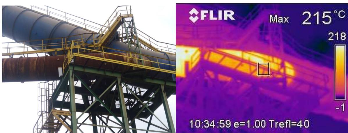
Figura 41 – Junção do duto primário (cor azul) com o duto secundário: detalhe (Cortesia Gerdau Guaíra)
