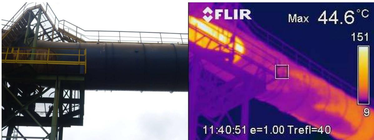
Figura 42 – Junção do duto primário com o duto secundário: mistura dos gases (Cortesia Gerdau Guaíra)
