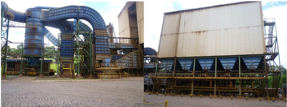
*Figura 8 – Câmara de mistura, ventiladores e casa de filtros de mangas (Cortesia Gerdau Guaíra)*
