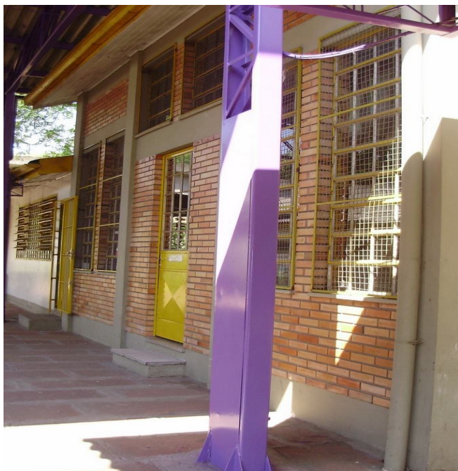
FIGURA 15 - Atelier construído em 2006, com um mezanino p/ cartonagem
