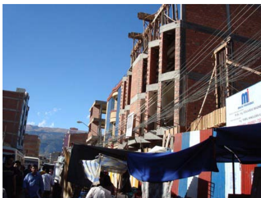
Fot. 49. Crescimento vertical Rua Esteban Arze
