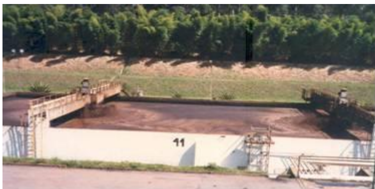
Figura 7- Bacia de equalização de um tratamento primário.
