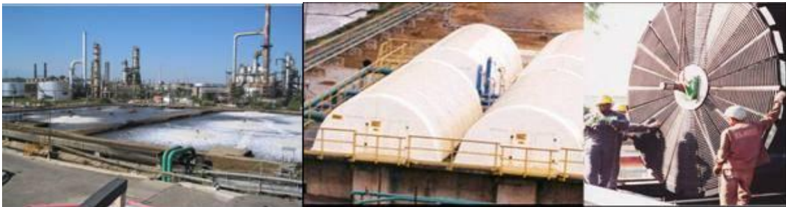
Figura 8- Fotos ilustrativas de diferentes sistemas de tratamento biológico: figura da esquerda, lagoas aeradas; outras, biodiscos.
