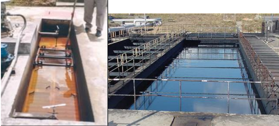
Figura 4- Exemplos de separadores água/óleo, PPI e API respectivamente.
