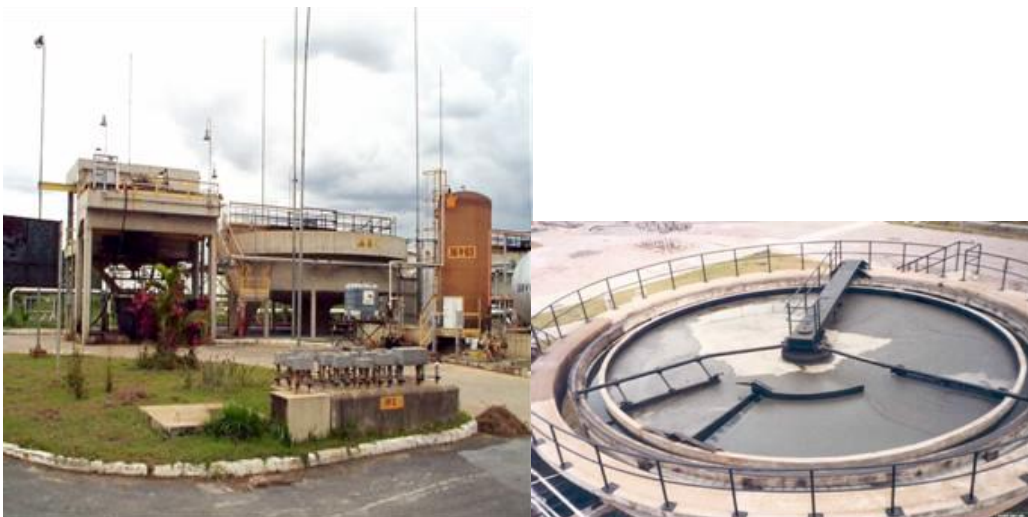
Figura 5- Flotador a ar dissolvido e a ar induzido, respectivamente.
