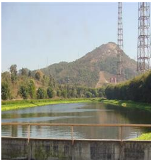
Figura 9- Foto da lagoa de polimento da REGAP.
