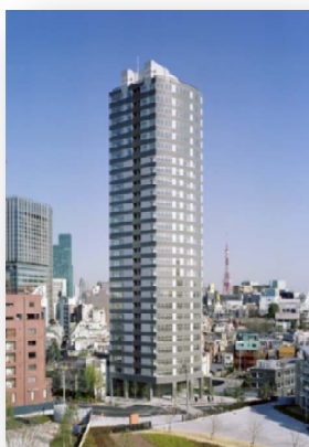
Figura 2.39: Edifício residencial Glorio Roppongi, localizado em Tóquio, Japão, utiliza vigas de ligação em ECC, que oferecem resistência sísmica à estrutura (Kajima Corporation – finalizada em 2006) .
