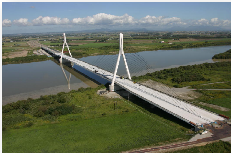
Figura 2.37: Mihara Bridge, Japão [fonte: Kunieda e Rokugo, 2006].
