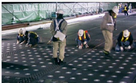
Figura 2.38: (a) Estrutura de aço pronta para recebimento do cobrimento em ECC e (b) moldagem do pavimento.
