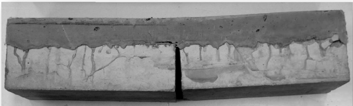
Figura 7.4: Comparação do padrão de fissuração dos recapeamentos de concreto, PVAECC e PPECC sob carregamento monotônico de flexão.
