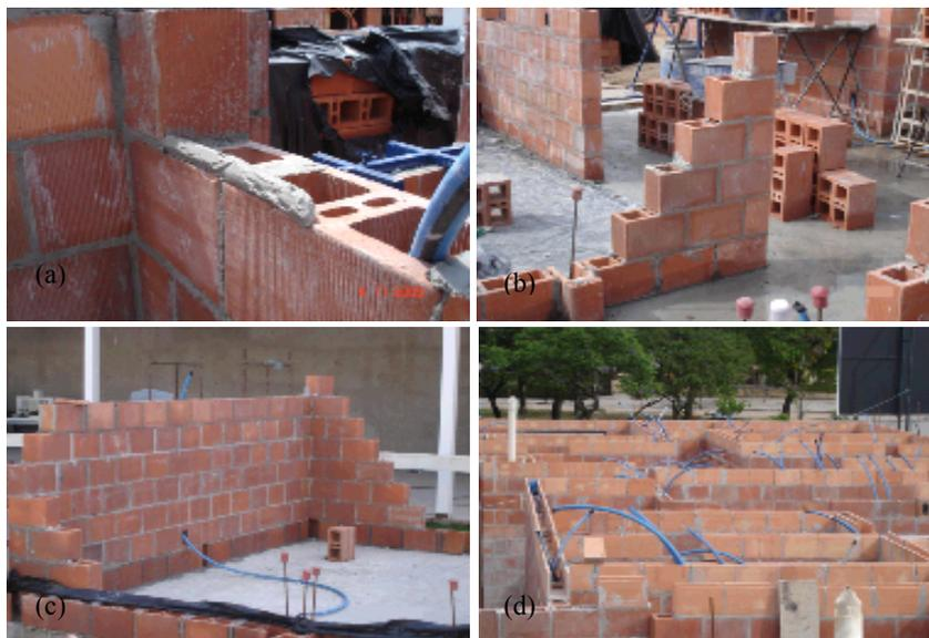
Figura 5: (a) colocação de massa para assentamento do bloco;
