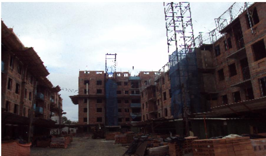
Figura 10: torres de alvenaria e elevadores de carga para transporte vertical
