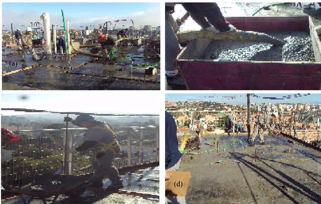
Figura 18: (a) disposição das caixas e mangote da bomba na laje; (b) lançamento do graute nas caixas; (c) adensamento do graute com barra de aço auxiliar; (d) limpeza do assoalho após grauteamento
