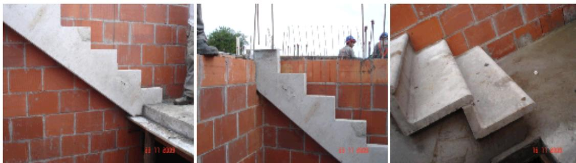
Figura 7: exemplo de escadas pré-moldadas
