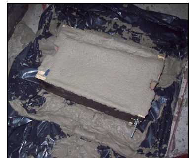
Figura 13 argamassa após a aplicação
